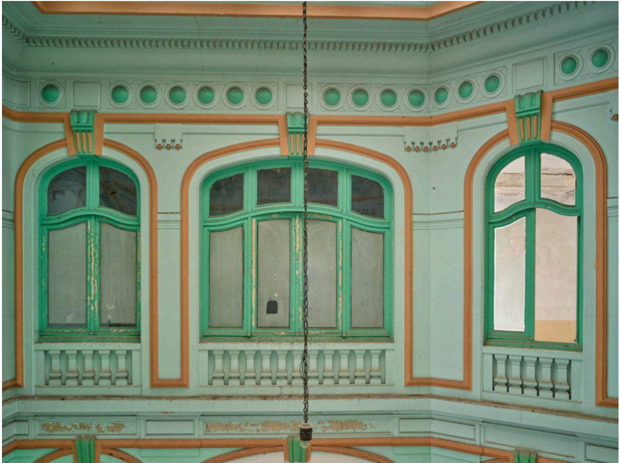
Bâtiment central. Détail du premier niveau de la partie sud du vestibule.
