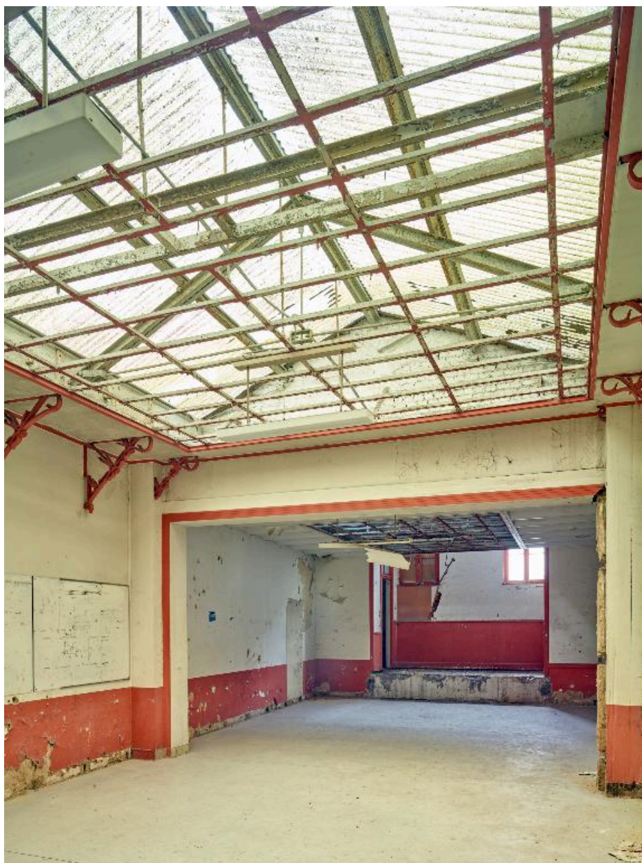
Bâtiment technique, rez-de-chaussée. Vue vers l'est.
