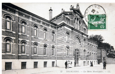
Façade et entrée sur la rue, carte postale (Médiathèque municipale de Tourcoing). Phot. Pierre Thibaut IVR32_20165900628NUCA
