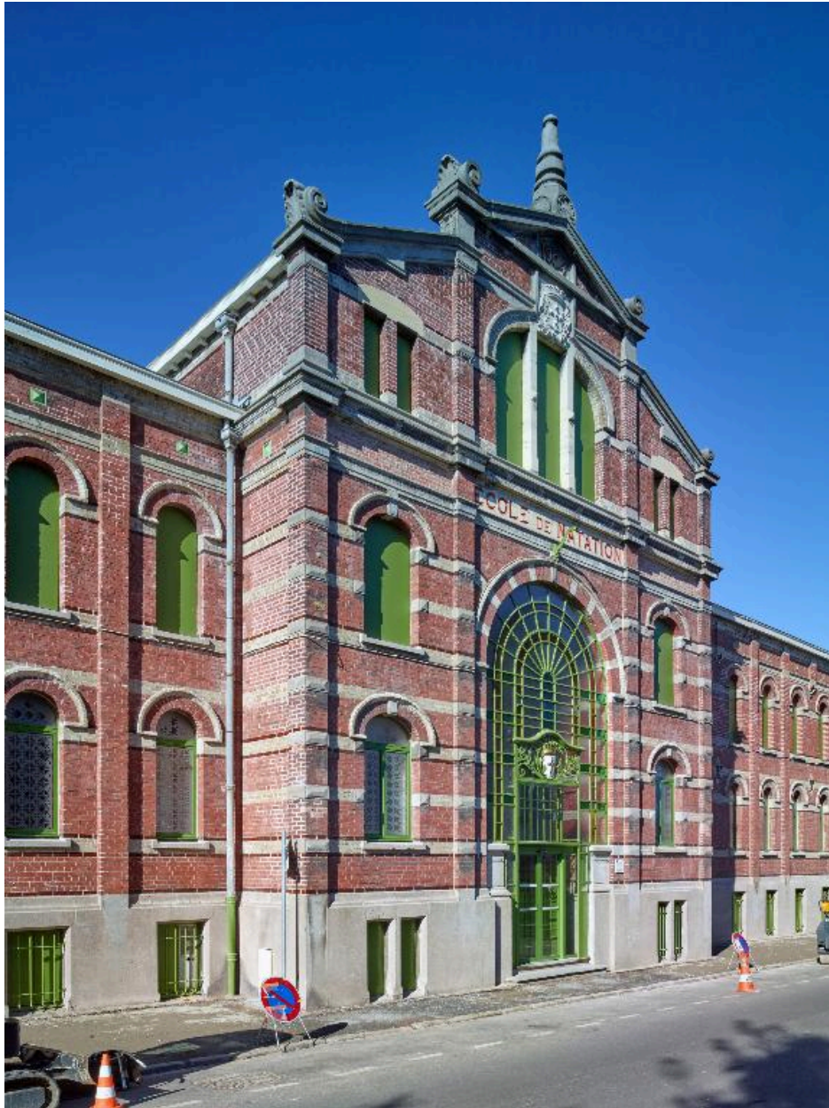
Vue du bâtiment d'entrée.
