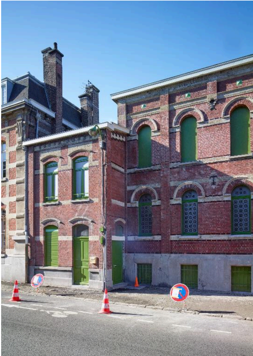
Vue du bâtiment du gardien, à l'extrémité sud de la façade sur rue.
