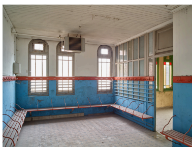
Aile nord, premier étage. Ancienne hydrothérapie des bains de luxe pour hommes, réaménagée en vestiaire collectif. Vue vers le nord, détail de l'entrée.
