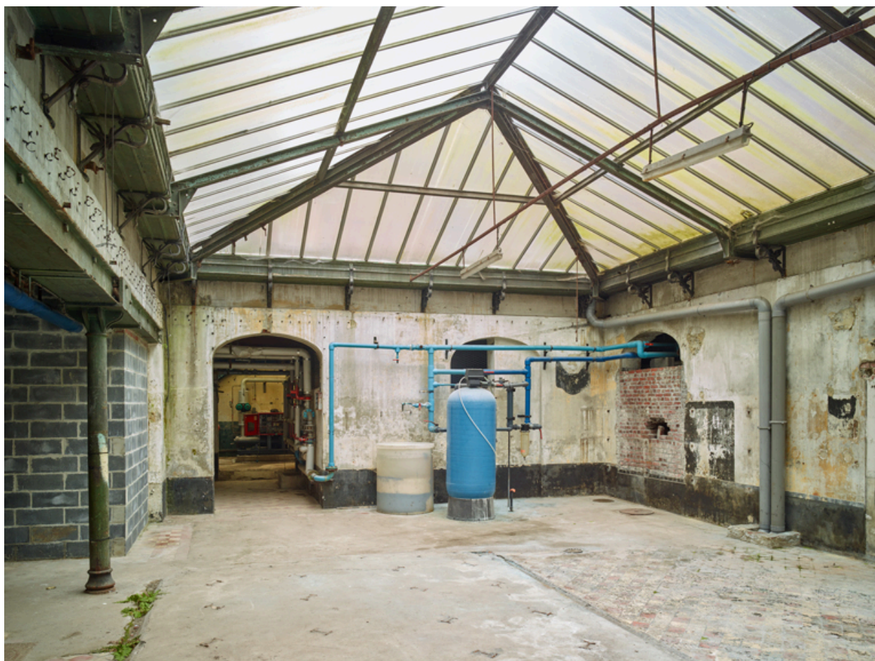
Aile sud, sous-sol. Vue générale de la cour vitrée de la lingerie vers le sud.
