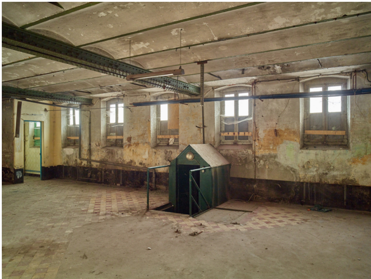
Aile nord, sous-sol. Vue générale du lavoir et de l'entrée du passage souterrain communiquant avec le stade nautique.
