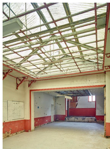
Bâtiment technique, rez- de-chaussée. Vue vers l'est. Phot. Pierre Thibaut IVR32_20165900354NUCA
