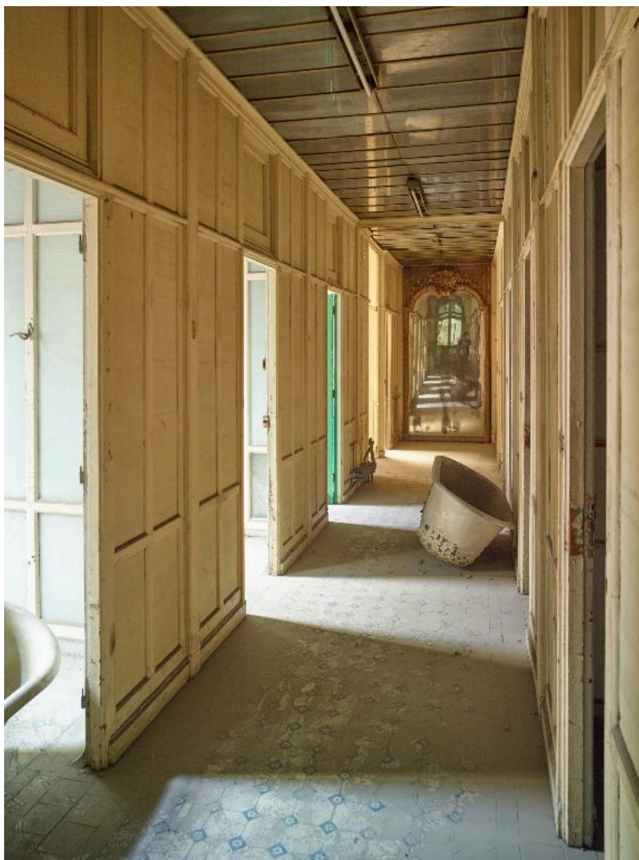
Aile nord, premier étage. Bains de baignoires de luxe pour hommes. Vue, du couloir distribuant les cabines, vers le nord.
