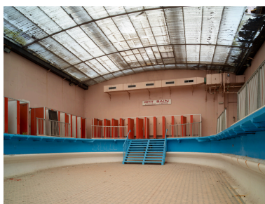
Vue du petit bain, depuis le centre du bassin. Phot. Pierre Thibaut IVR32_20165900380NUCA
