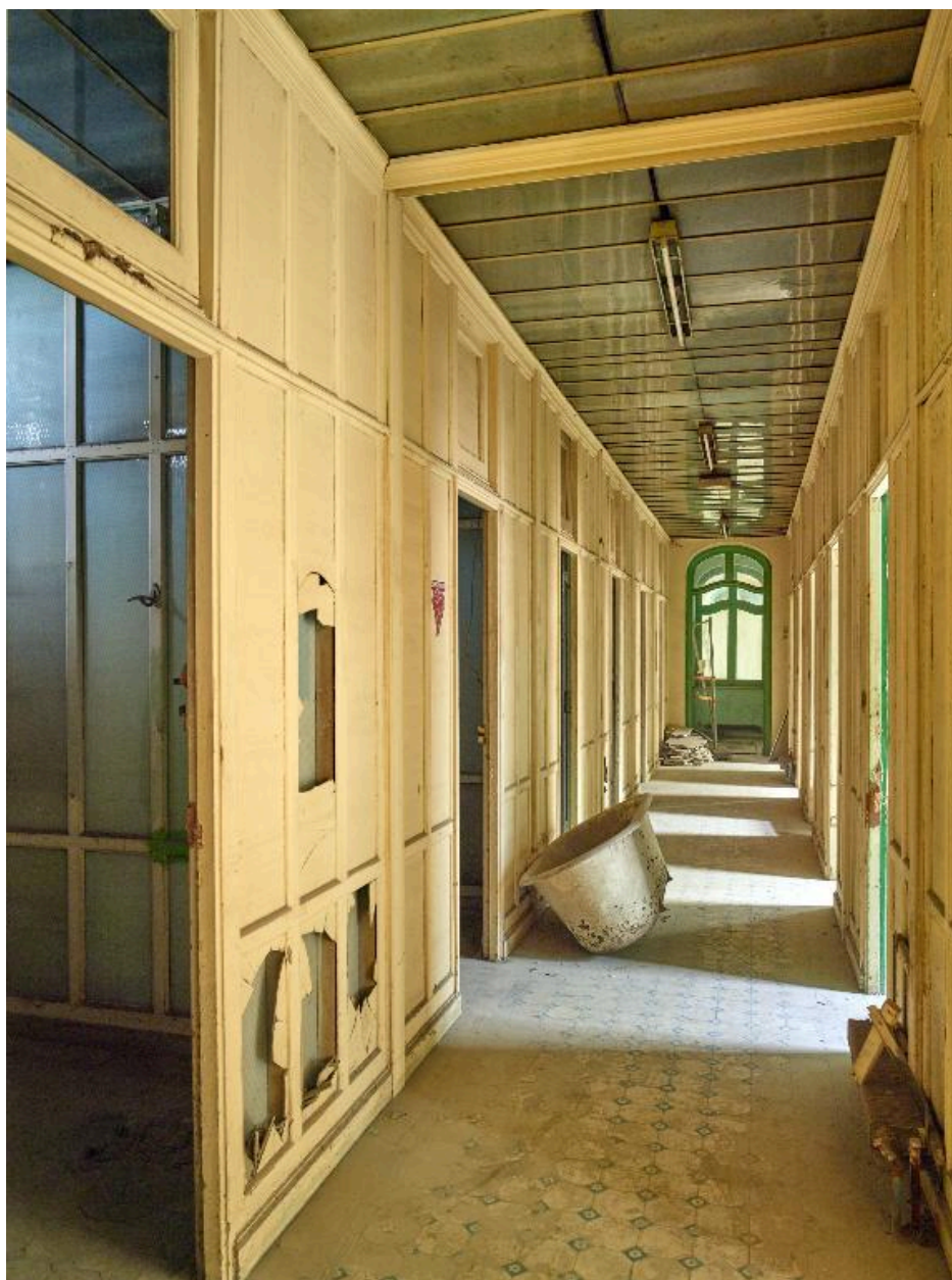
Aile nord, premier étage. Bains de baignoires de luxe pour hommes. Vue vers le sud, depuis le couloir distribuant les cabines.
