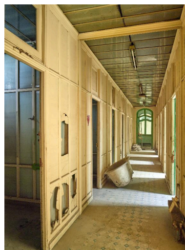
Aile nord, premier étage. Bains de baignoires de luxe pour hommes. Vue vers le sud, depuis le couloir distribuant les cabines. Phot. Pierre Thibaut IVR32_20165900409NUCA
