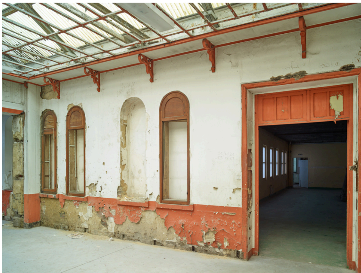
Bâtiment technique, rez-de-chaussée. Vue des baies de l'ancienne hydrothérapie des bains de baignoires de luxe pour dames, donnant sur la cour intérieure.
