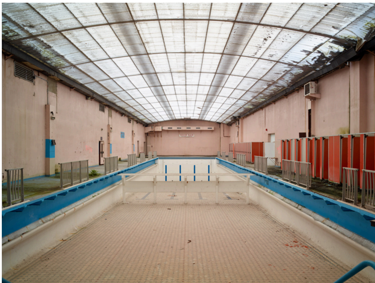
Vue générale axiale du bassin, vers le nord (grand bain).
