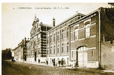
Vue générale de la façade depuis le nord avec au premier plan le bâtiment technique, carte postale (Médiathèque municipale de Tourcoing). Phot. Pierre Thibaut IVR32_20165900625NUCA
