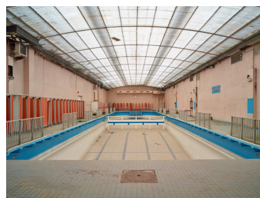
Vue générale axiale du bassin, vers le sud (petit bain).
