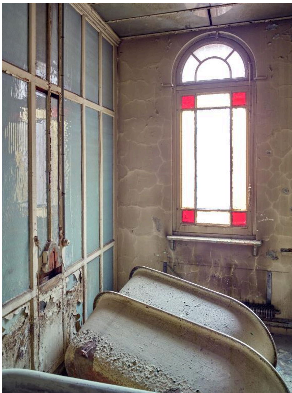
Aile nord, premier étage. Bains de baignoires de luxe pour hommes. Vue de trois quarts de la deuxième cabine à gauche.
