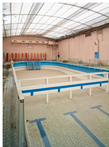
Vue de trois quarts de la séparation des bains. Phot. Pierre Thibaut IVR32_20165900393NUCA
