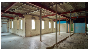
Aile sud, rez-de-chaussée. Vue générale des anciens bains de baignoires à prix réduits pour dames. Phot. Pierre Thibaut IVR32_20165900414NUCA
