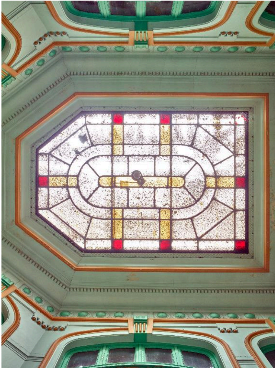
Bâtiment central. Vue de la verrière du vestibule.
