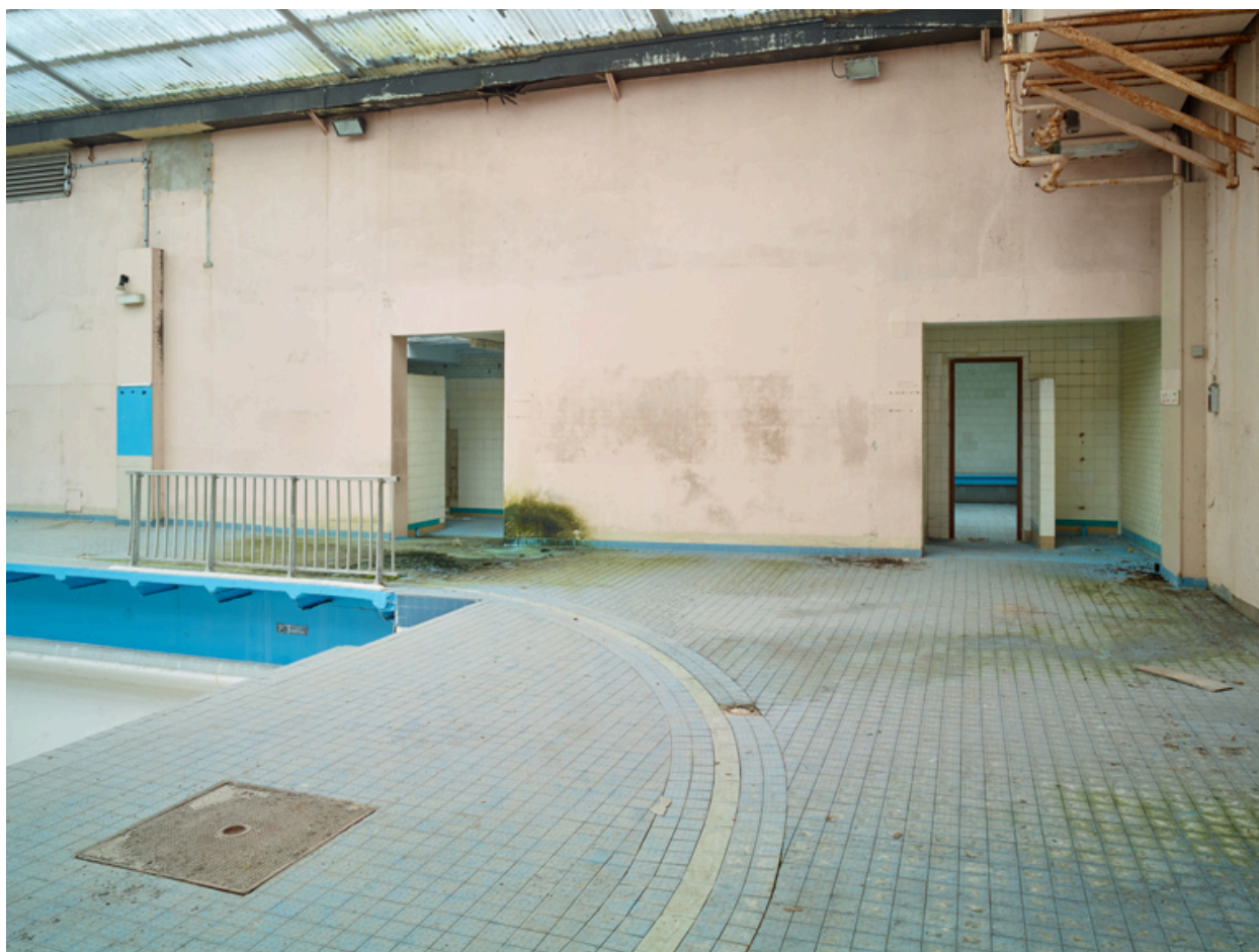
Détail de l'entrée de l'hydrothérapie du bassin de natation.
