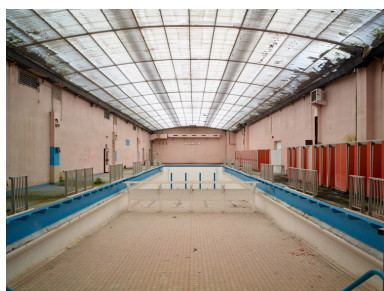
Vue générale axiale du bassin, vers le nord (grand bain). Phot. Pierre Thibaut IVR32_20165900377NUCA
