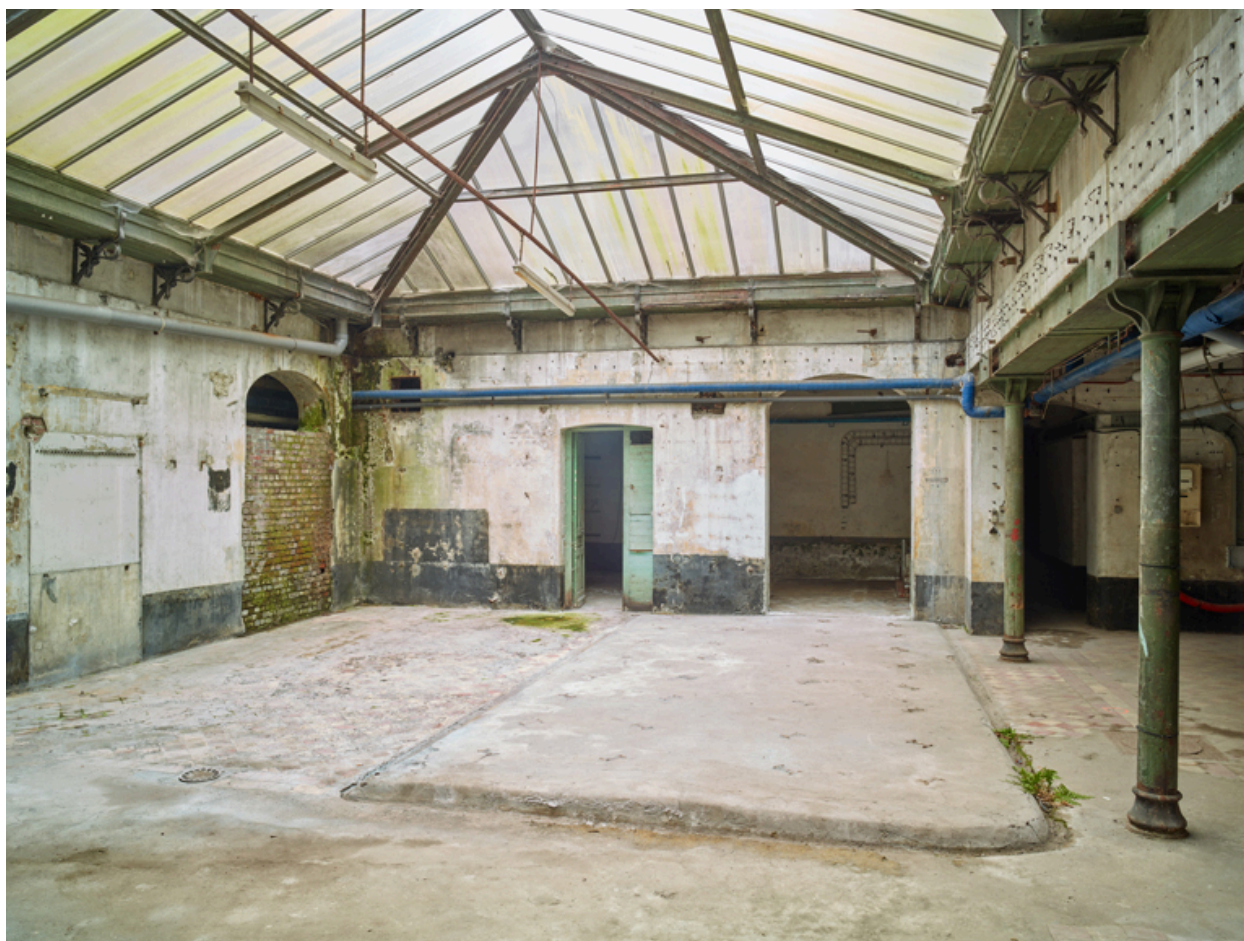
Aile sud, sous-sol. Vue générale de la cour vitrée de la lingerie vers le nord.
