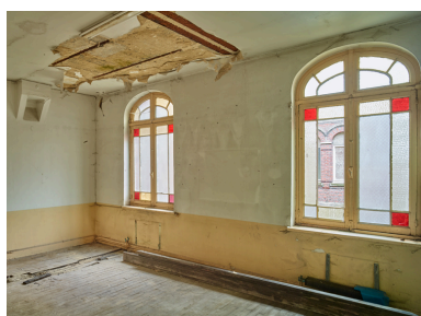
Bâtiment central, premier étage. Logement du directeur : vue du salon-salle à manger. Phot. Pierre Thibaut IVR32_20165900366NUCA
