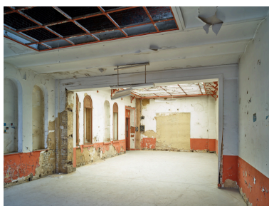
Bâtiment technique, rez-de-chaussée. Vue vers l'ouest. Phot. Pierre Thibaut IVR32_20165900356NUCA
