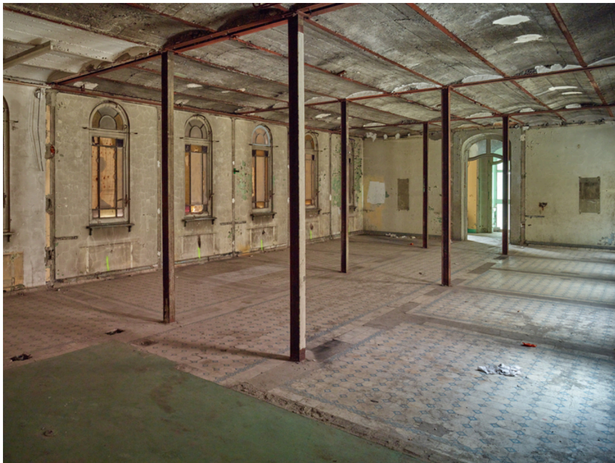
Aile nord, rez-de-chaussée. Vue générale des anciens bains de baignoires de luxe pour dames, vers les fenêtres de la façade.
