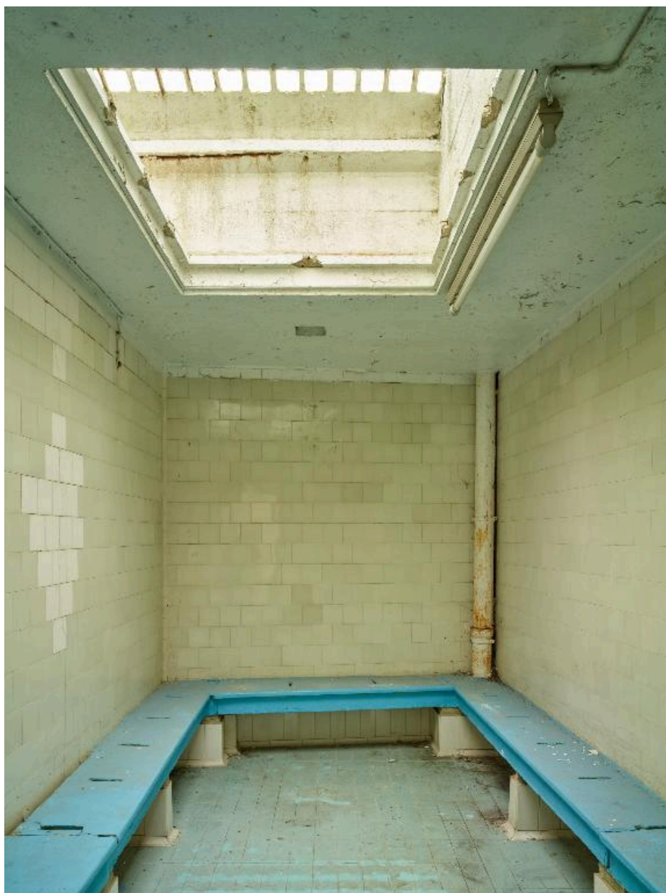
Hydrothérapie du bassin de natation : vue l'ancienne salle de massage remaniée, depuis l'entrée.
