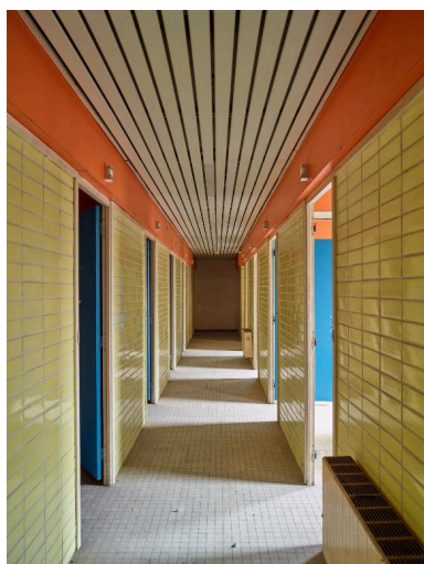
Aile sud, premier étage. Bains de baignoire à prix réduit pour hommes, remaniés. Vue du couloir vers le sud.
