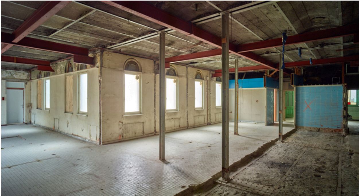
Aile sud, rez-de-chaussée. Vue générale des anciens bains de baignoires à prix réduits pour dames.
