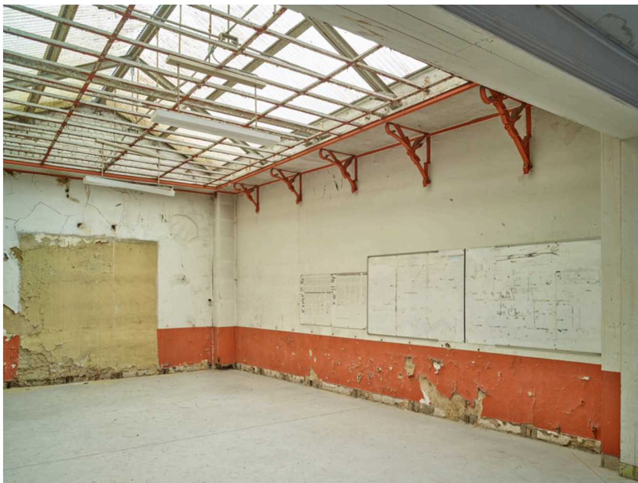
Bâtiment technique, rez-de-chaussée. Vue vers le nord, détail de la charpente métallique de la cour intérieure.
