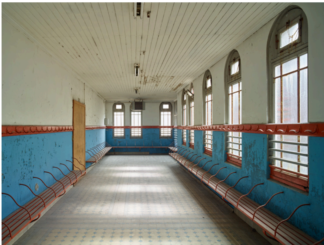
Aile nord, premier étage. Ancienne hydrothérapie des bains de luxe pour hommes, réaménagée en vestiaire collectif. Vue vers le nord.
