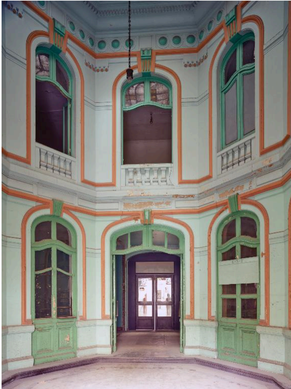
Bâtiment central. Vue générale du vestibule depuis l'entrée.
