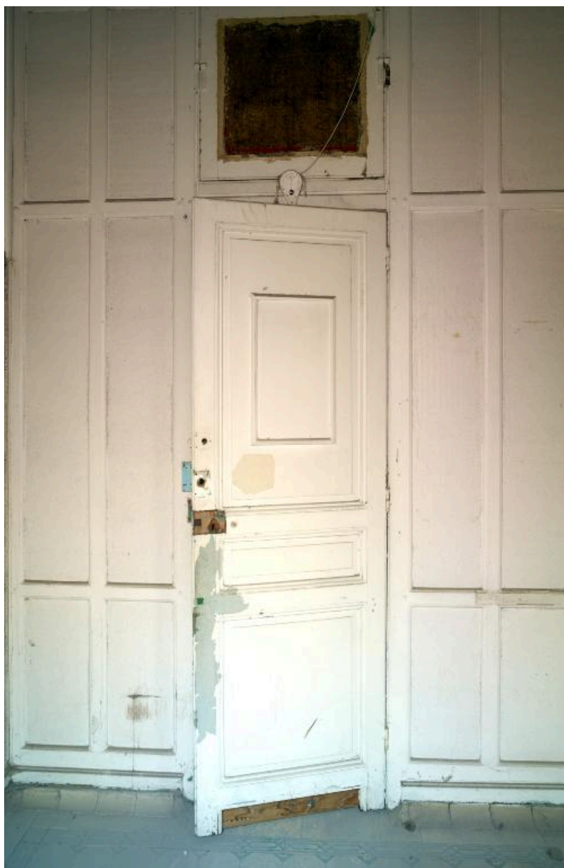
Aile nord, premier étage. Bains de baignoires de luxe pour hommes. Détail intérieur de la porte de la première cabine à gauche.
