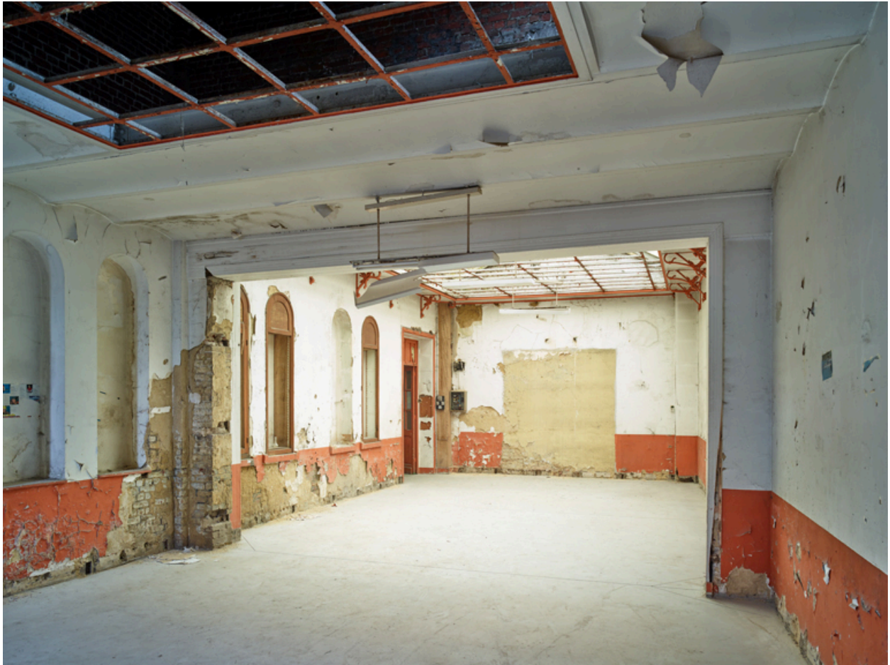
Bâtiment technique, rez-de-chaussée. Vue vers l'ouest.
