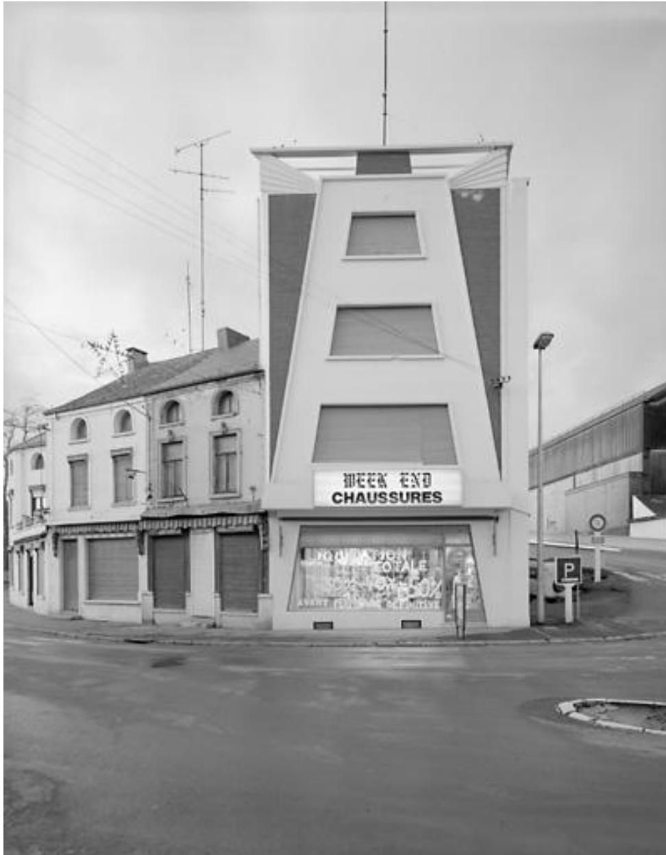
Vue générale de l'élévation antérieure.
