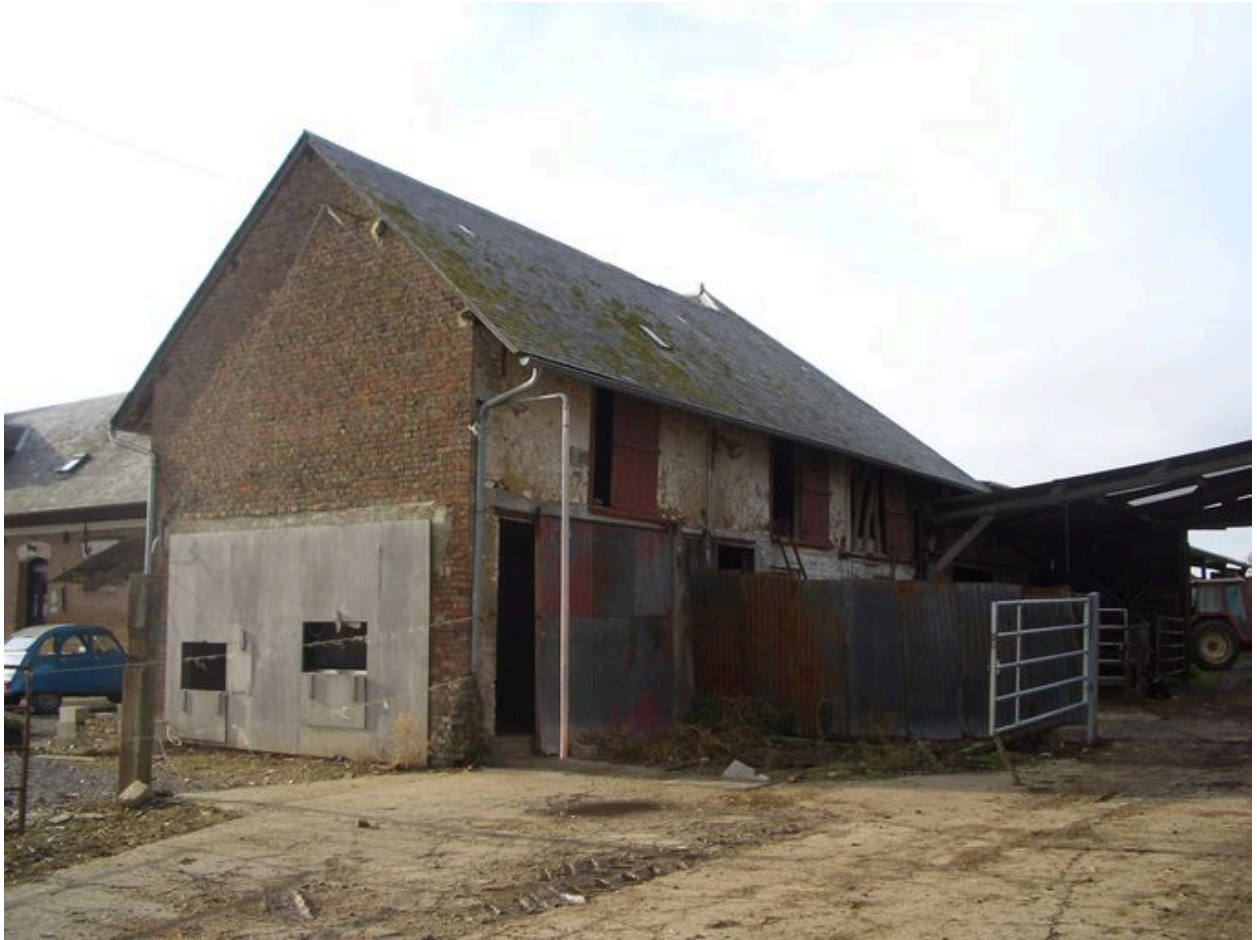
Vue postérieure de ce bâtiment.
