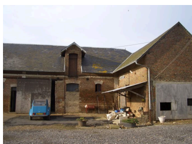
Vue depuis la cour des anciennes étables dans le prolongement du logis.
