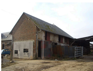
Vue postérieure de ce bâtiment.
