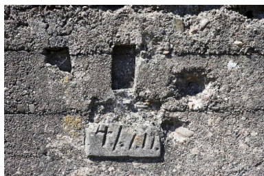
Date portée sur l'élévation sud Phot. Pierre Thibaut IVR32_20165901346NUCA
