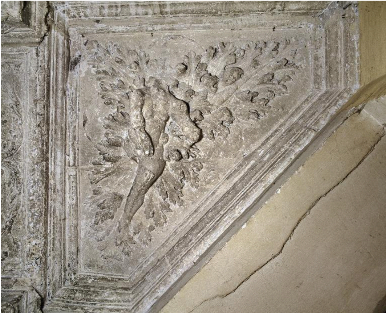
Vue d'un caisson : personnage féminin.
