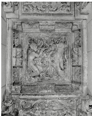
Vue d'un caisson :
