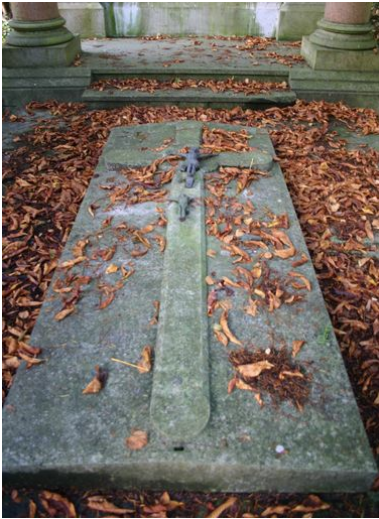
Dalle fermant l'entrée du caveau. Phot. Caroline Vincent IVR22_20078001194NUCA
