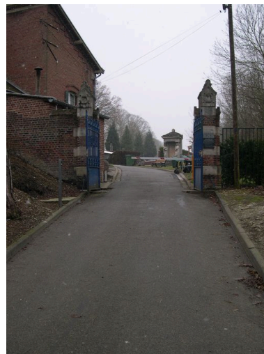
Le portail d'entrée, rue d'Elbeuf. Phot. Isabelle Barbedor IVR22_20058010544NUCA
