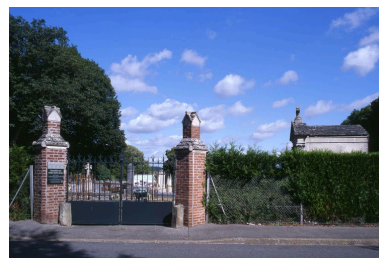
Le portail d'entrée, rue Lescouvé. Phot. Marie-Laure Monnehay-Vulliet IVR22_20078000203XA
