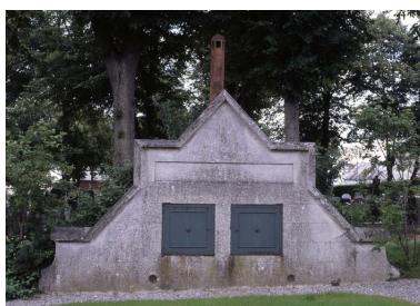
Le dépositaire, vue depuis le sud. Phot. Marie-Laure Monnehay-Vulliet IVR22_20078000220XA
