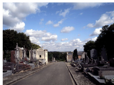
Vue de l'allée principale, depuis la rue Lescouvé. Phot. Marie-Laure Monnehay-Vulliet IVR22_20078000205XA
