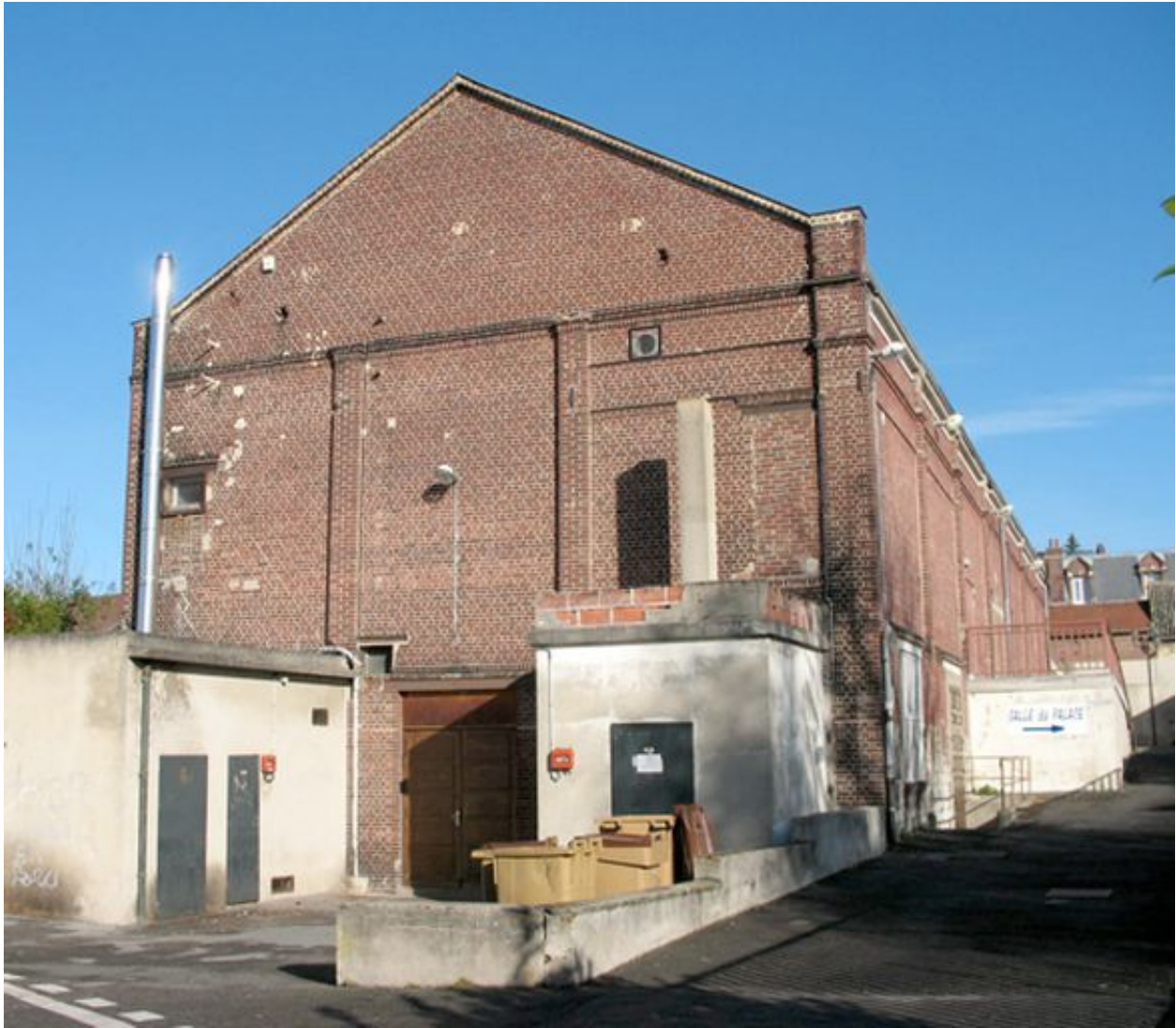
Bâtiment de la salle des fêtes.
