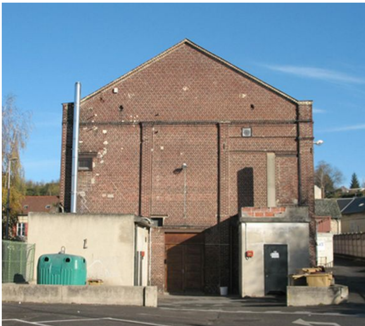
Façade sud de la salle des fêtes.
