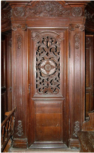
Elévation de la partie centrale. Phot. Frédéric Fournis IVR22_20118001471NUCA
