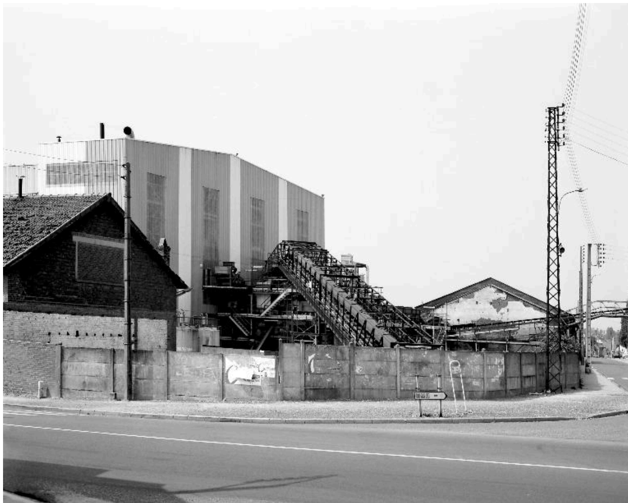
Atelier de fabrication, vue partielle, flanc nord.
