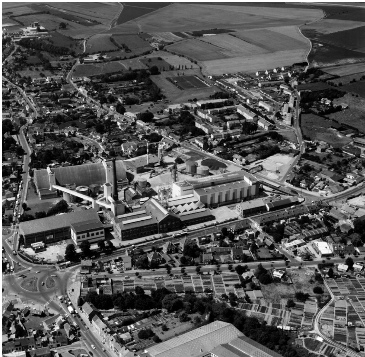
Vue aérienne de 1990, flanc est.
