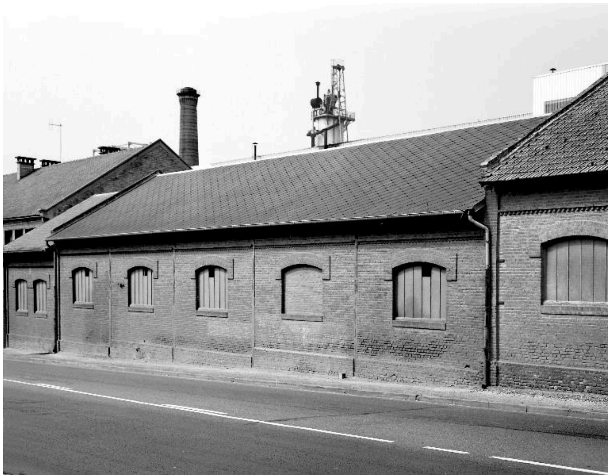
Vue de la façade est d'un atelier.
