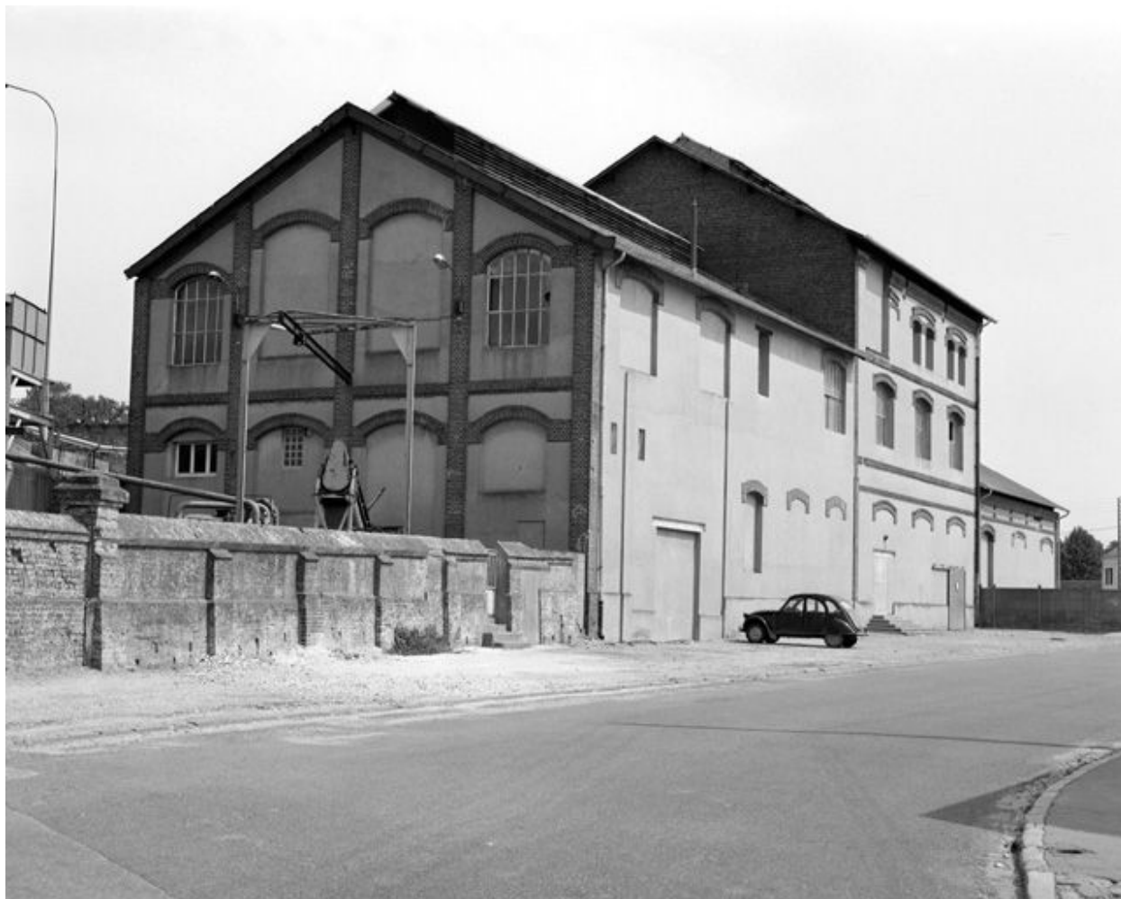
Râperie, flanc sud-ouest.
