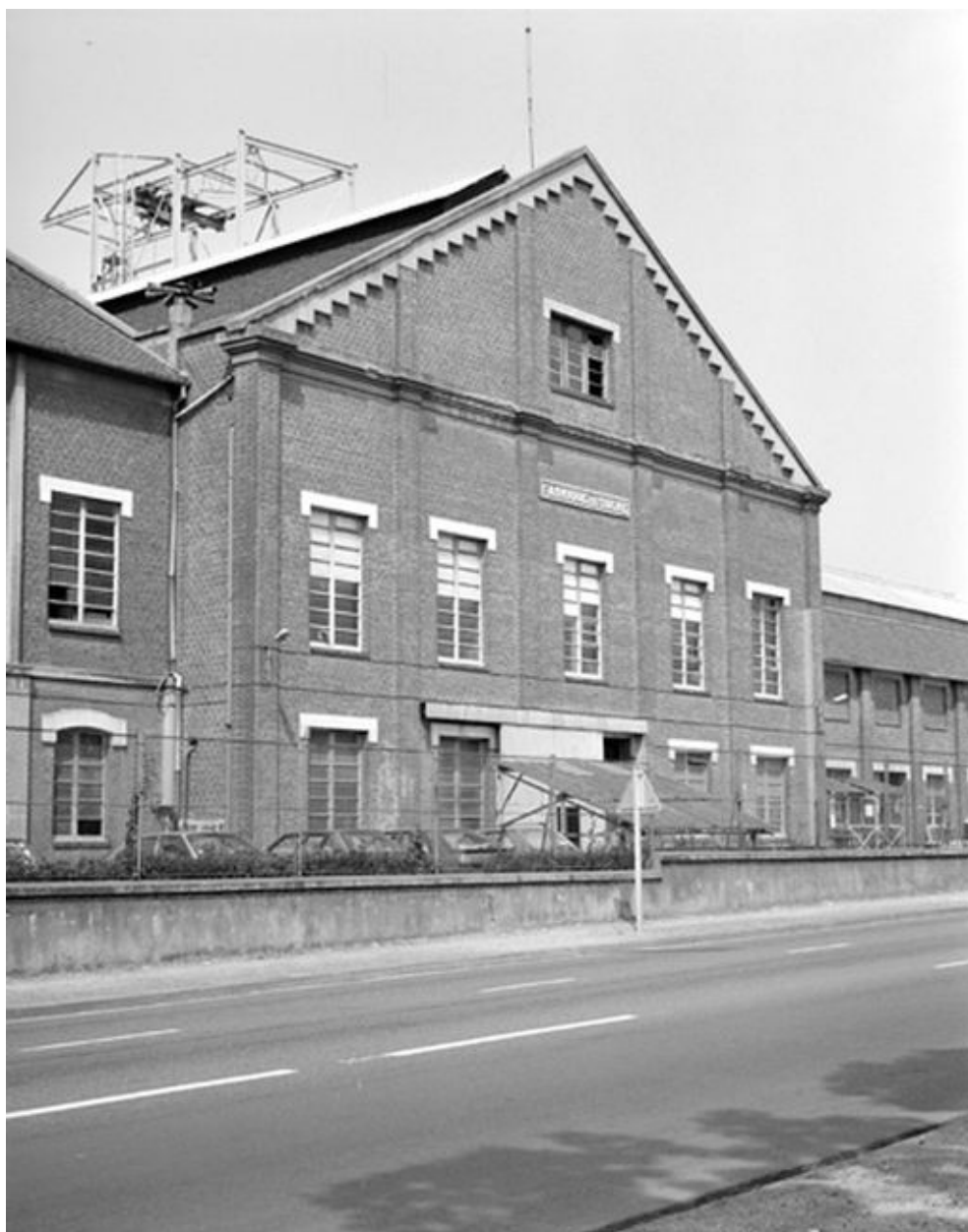
Atelier de fabrication, vue partielle, flanc est.
