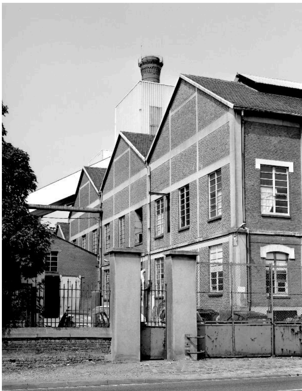
Atelier de fabrication, flanc sud-ouest.
