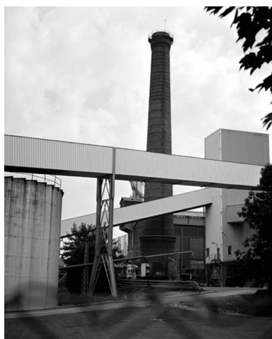
Vue de la cheminée d'usine. Phot. Benoît Dufournier IVR22_19888000841X
