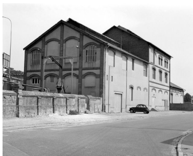
Râperie, flanc sud-ouest. Phot. Benoît Dufournier IVR22_19888000952X
