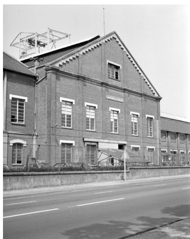
Atelier de fabrication, vue partielle, flanc est. Phot. Benoît Dufournier IVR22_19888000956X
