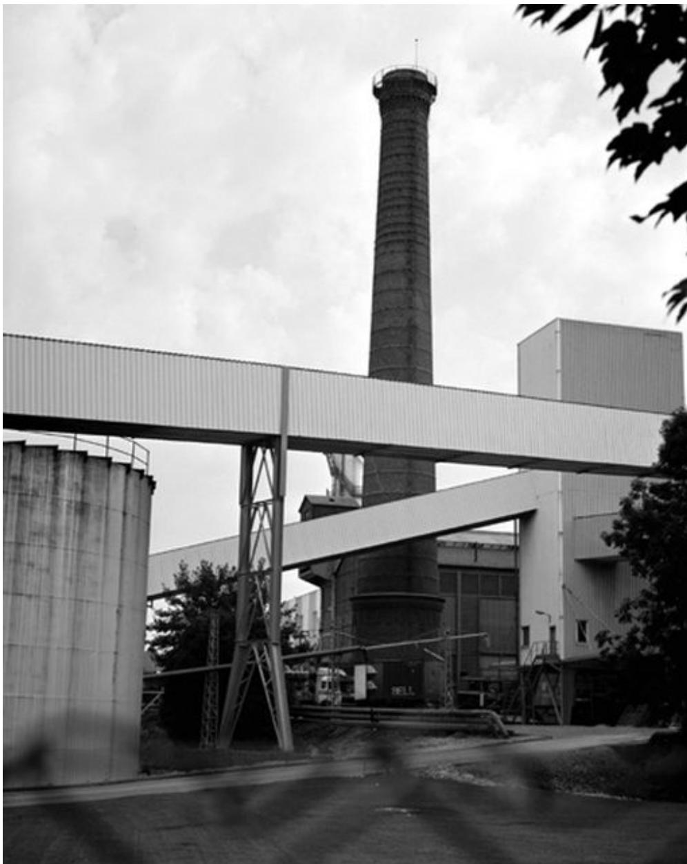
Vue de la cheminée d'usine.
