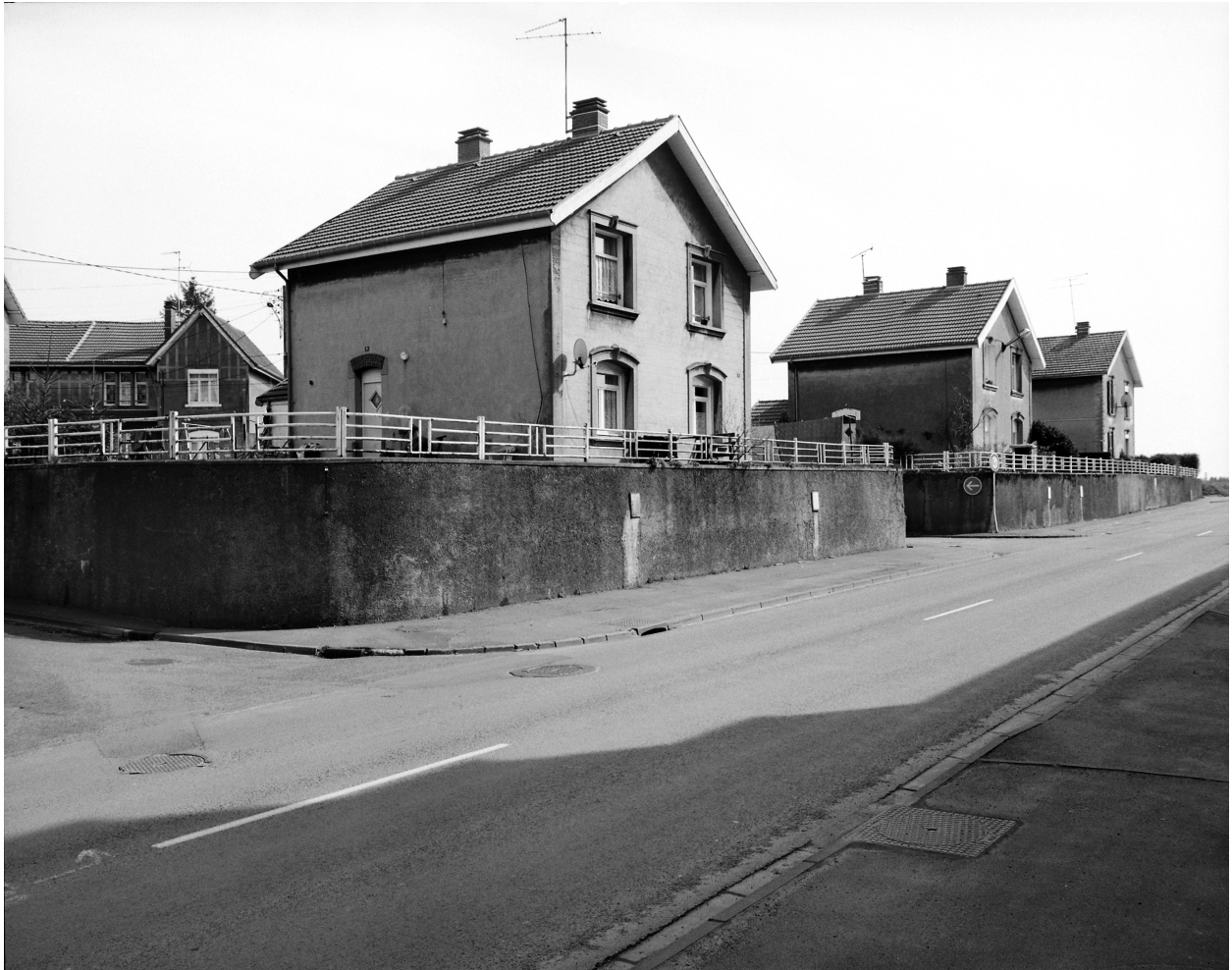
Vue partielle de la série : alignement de trois maisons.
