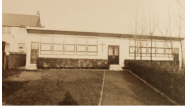
Vue générale Phot. Céline Frémaux IVR31_20055907228NUCB
