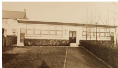
Vue générale Phot. Céline Frémaux IVR31_20055907228NUCB
