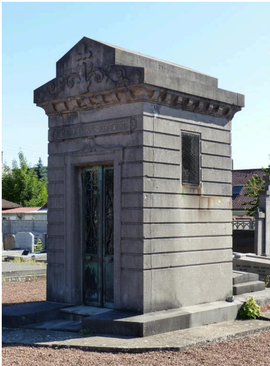
Plaine H (31). Tombeau (chapelle) de la famille Pierre-Bouresche. Allée principale de la première extension du cimetière.
