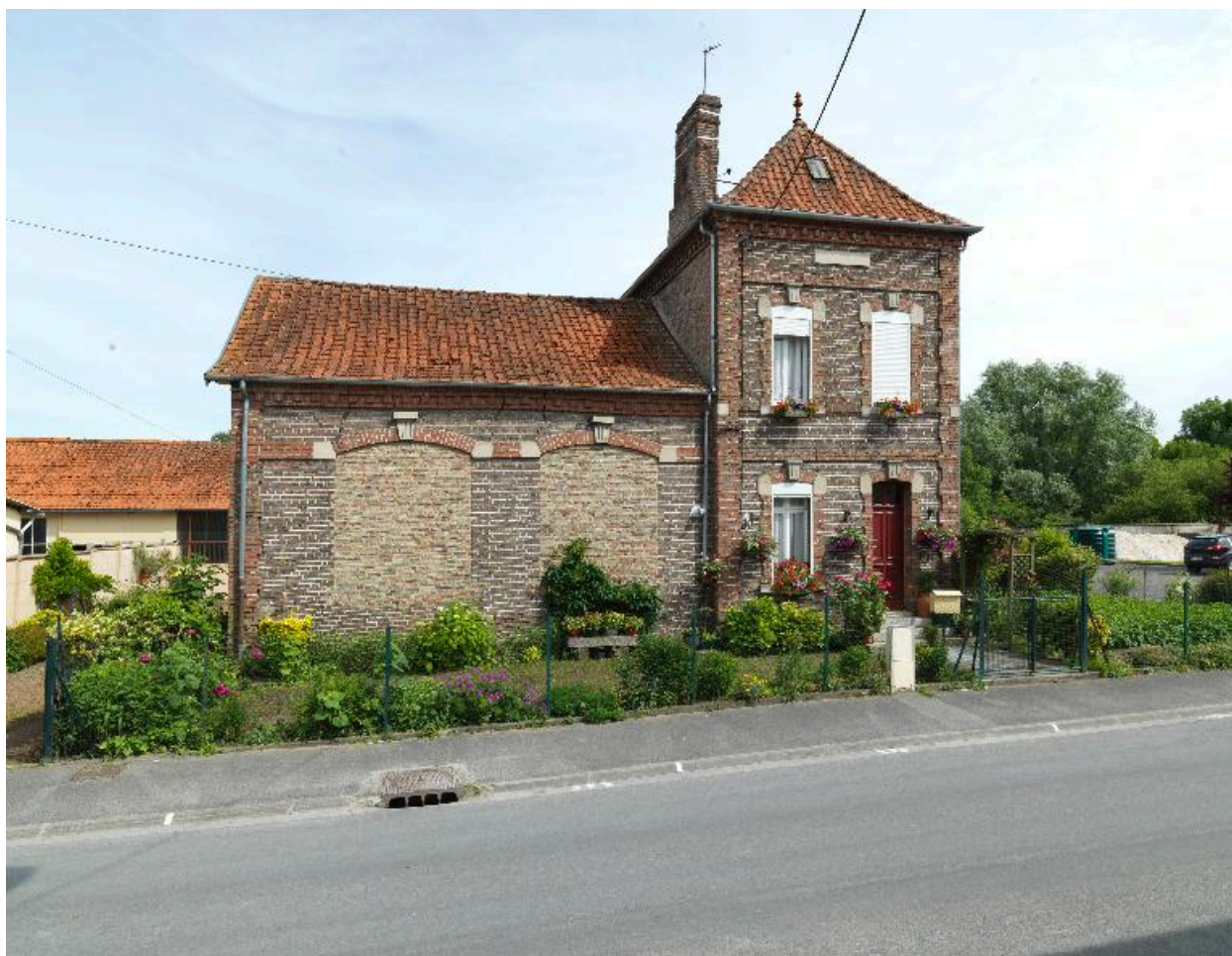
Vue de l'ancienne école primaire des Moulins-Bleus, façade sur rue.
