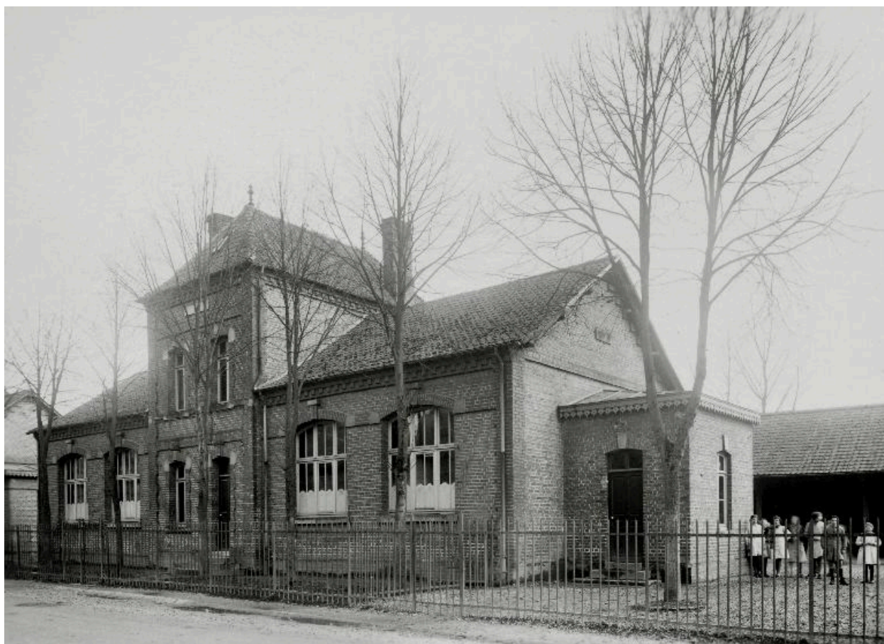
Vue d'ensemble extérieure de l'école des Moulins-Bleus en 1937 (coll. part.)
