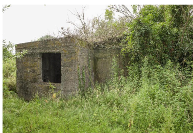
Casemate a), élévation ouest Phot. Jean-Marc Ramette IVR31_20145904908NUCA
