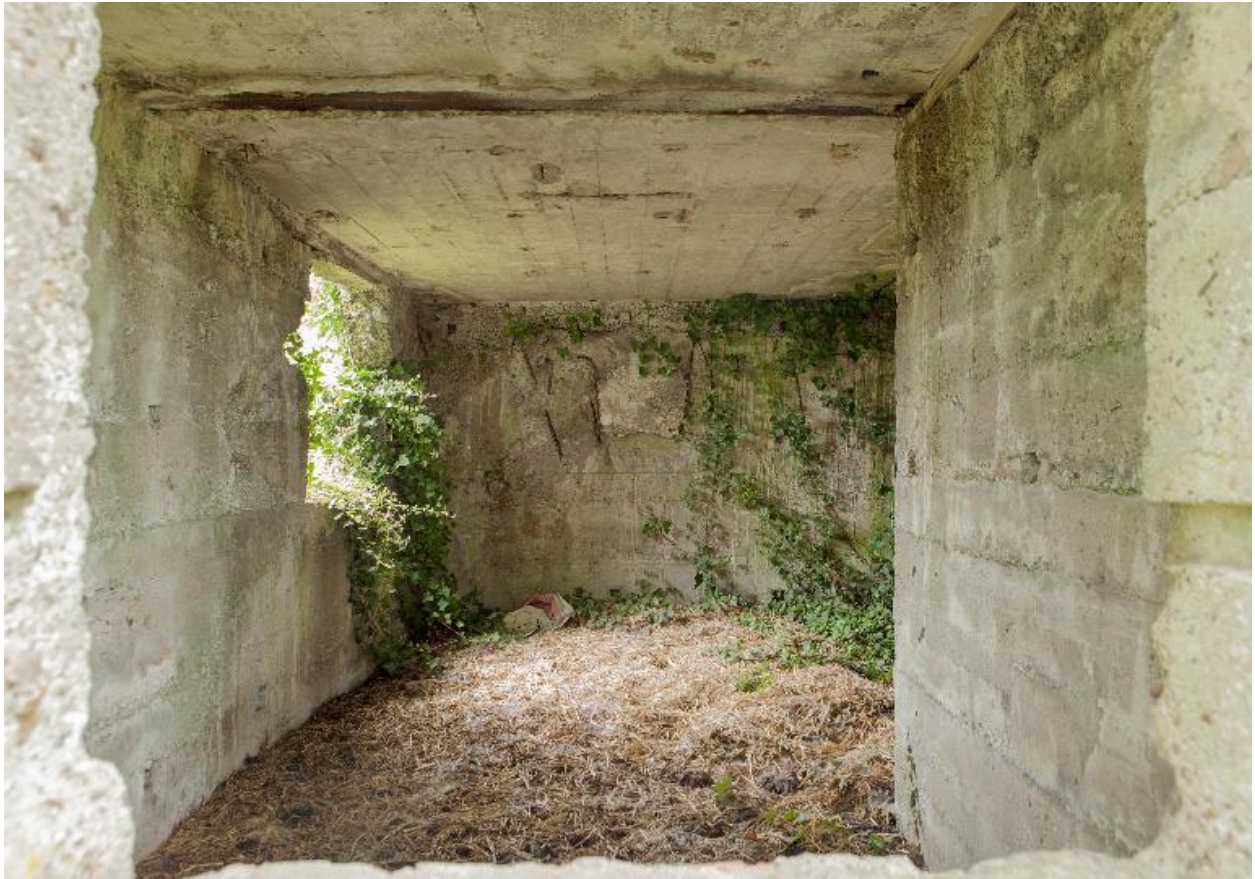
Casemate a), seconde salle en enfilade
