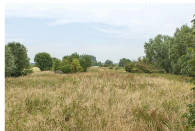
Vue générale vers le nord-ouest. A droite, la casemate a), à gauche les casemates b) et c). Au milieu et à l'arrière-plan, la casemate à mitrailleuse IA59004884 Phot. Jean-Marc Ramette IVR31_20145905180NUCA
