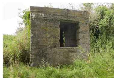
Casemate a), élévation ouest Phot. Jean-Marc Ramette IVR31_20145904910NUCA
