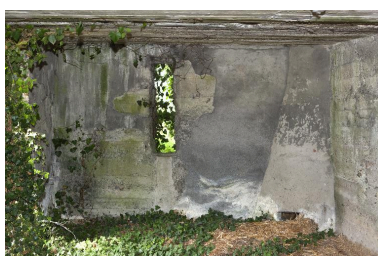
Casemate a). A droite une cheminée Phot. Jean-Marc Ramette IVR31_20145904913NUCA
