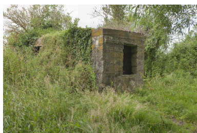
Casemate a), élévation ouest Phot. Jean-Marc Ramette IVR31_20145904909NUCA
