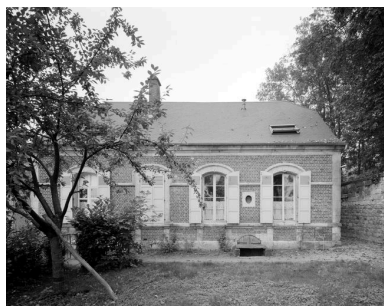
Élévation postérieure. Phot. Jean-Michel Perrin IVR22_19846001223V
