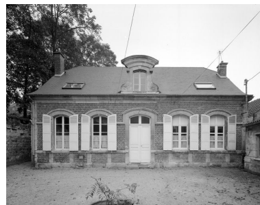
Élévation antérieure. Phot. Jean-Michel Perrin IVR22_19846001222V
