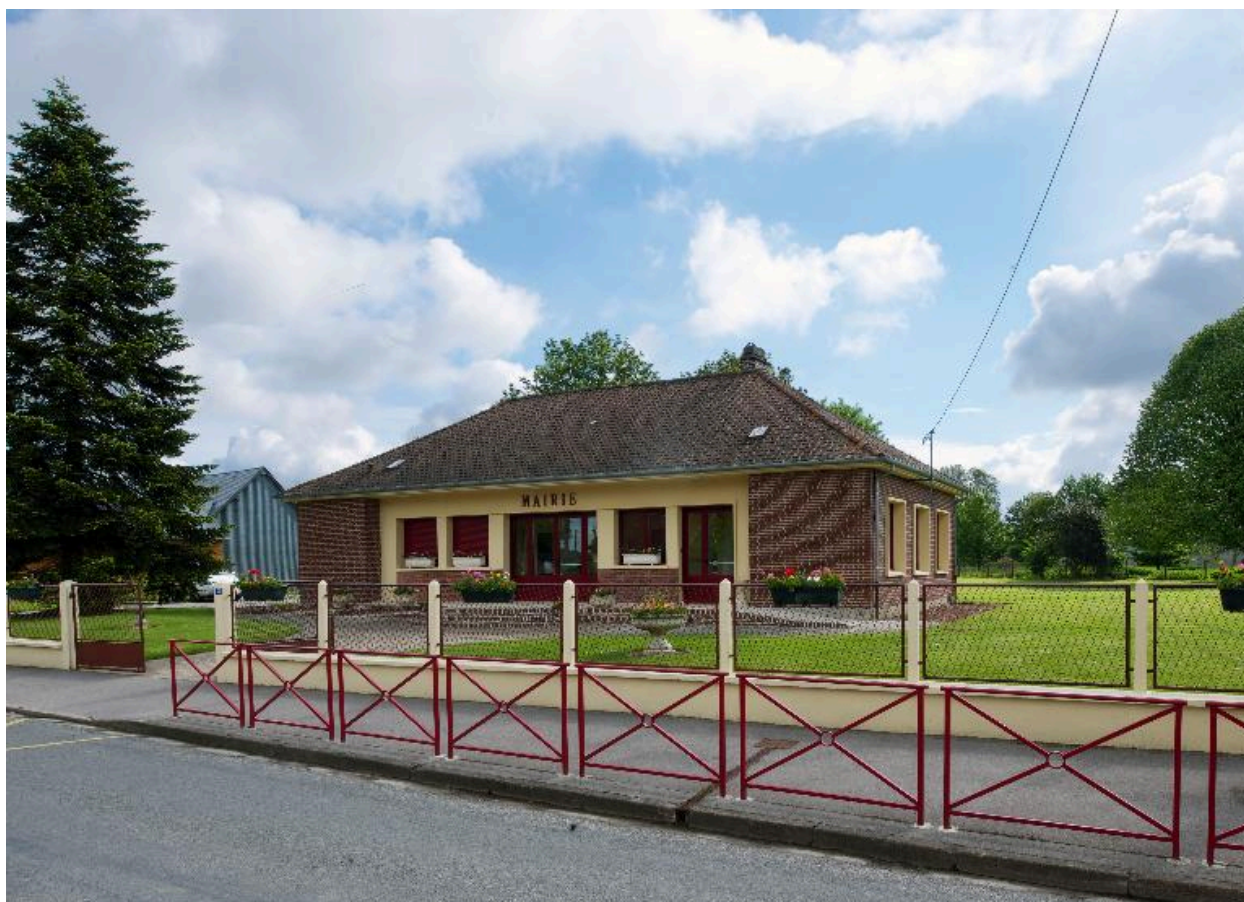
Vue générale depuis la rue du Presbytère.
