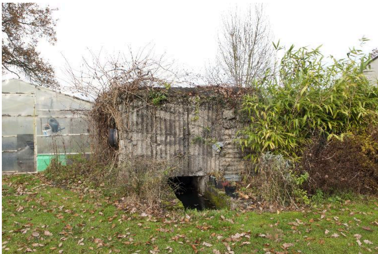
Elévation antérieure, entrée ouest
