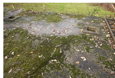
Depuis le couvrement, sortie des deux cheminée à périscope Phot. Jean-Marc Ramette IVR32_20175900179NUCA
