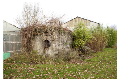
Elévation sud-ouest Phot. Jean-Marc Ramette IVR32_20175900180NUCA
