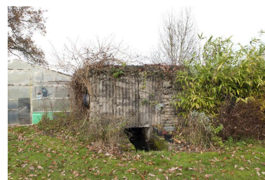
Elévation antérieure, entrée ouest Phot. Jean-Marc Ramette IVR32_20175900178NUCA
