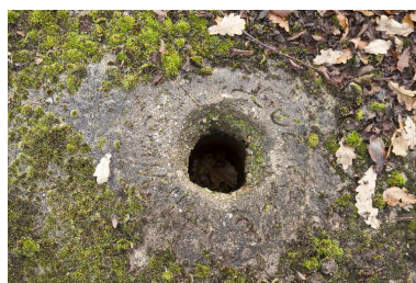
Signature (illisible) autour d'une sortie de cheminée d'aération. Phot. Jean-Marc Ramette
