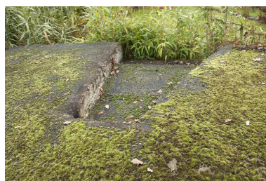
Blocage de l'affût de la mitrailleuse sur le couvrement. Phot. Jean-Marc Ramette IVR31_20145904428NUCA
