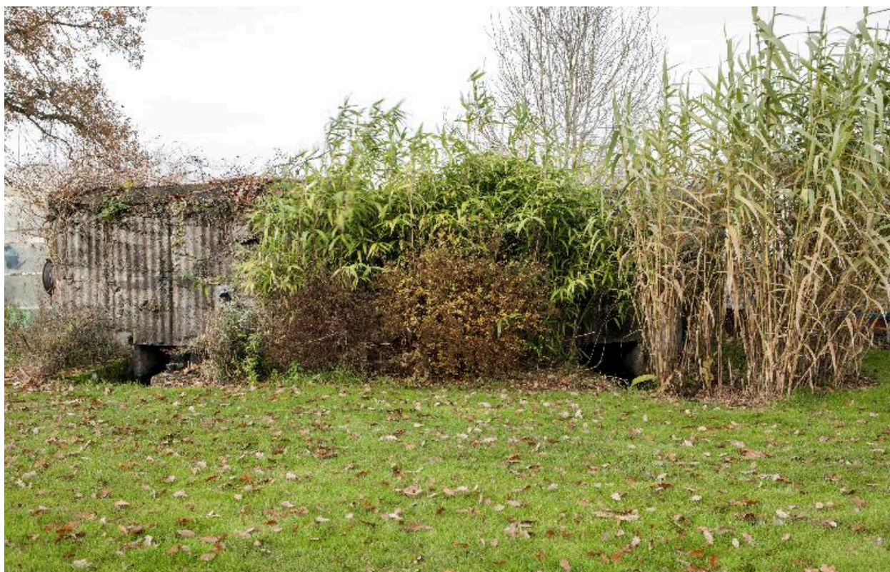
Elévation antérieure, vers le nord-ouest
