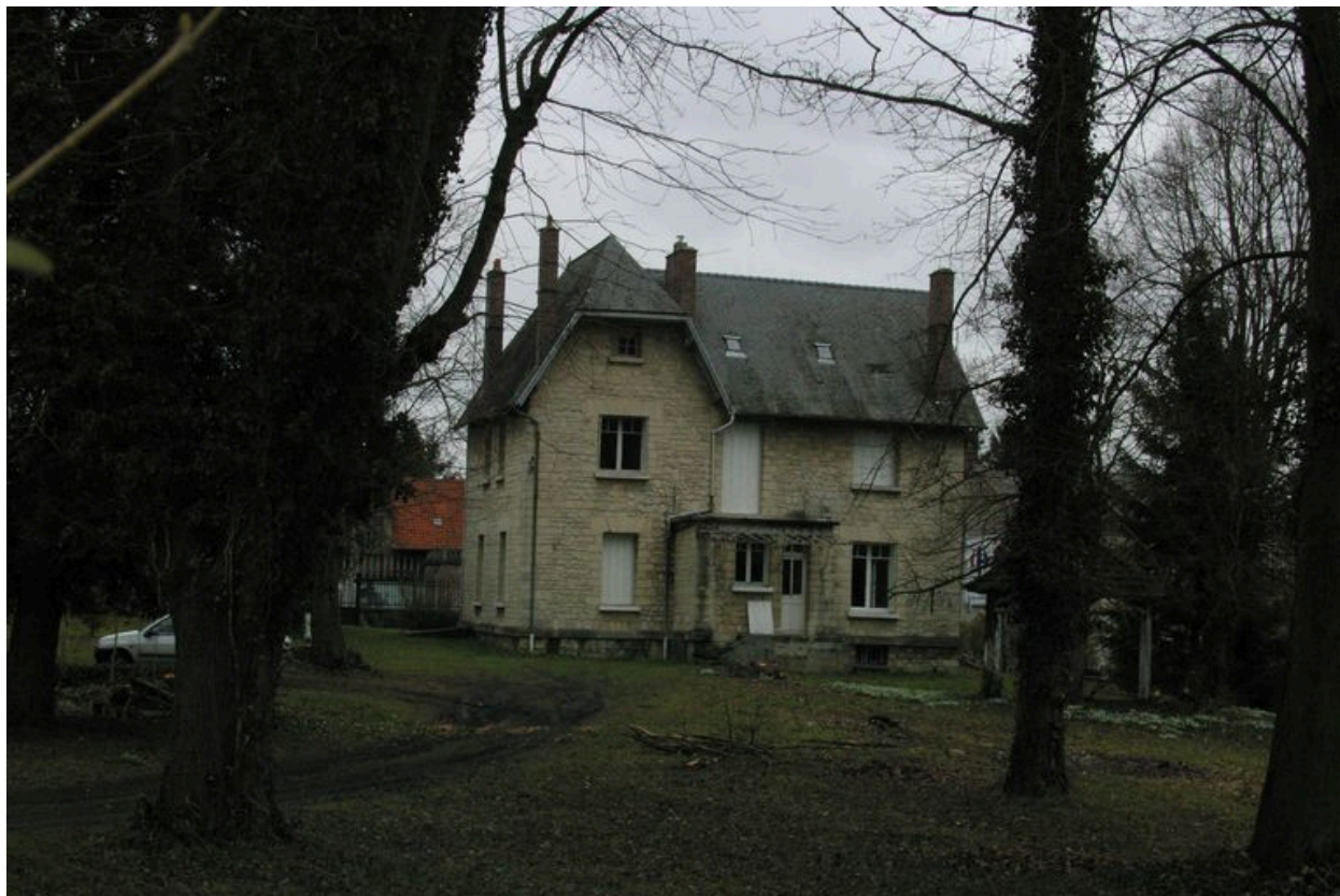
Vue postérieure de la maison.
