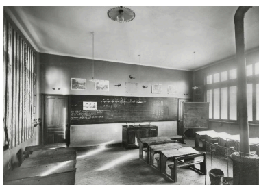
Vue intérieure d'une des classes de l'école, 23 février 1937 (coll. part.). Phot. Thierry Lefébure IVR22_20128000521NUC2A
