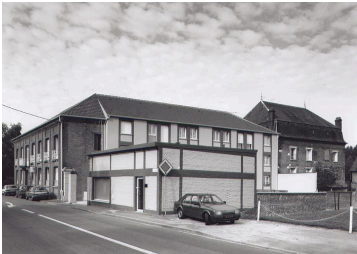
Vue d'ensemble des bâtiments, ancien logement patronal, depuis la rue Philéas-Lebesgue.
