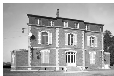
Façade postérieure du "Petit Château". Phot. Thierry Lefébure IVR22_19960200087P
