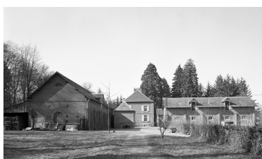
Métairie du château. Phot. Thierry Lefébure IVR22_19960200092V
