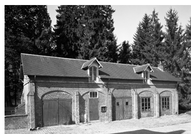
Anciennes remises. Phot. Thierry Lefébure IVR22_19960200091V
