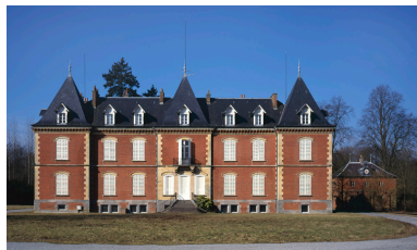
Vue de la façade est. Phot. Thierry Lefébure IVR22_19960200104VA
