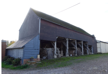
Ancienne charreterie sur rue, vue depuis la cour. Phot. Lucile Chamignon IVR32_20226005099NUCA
