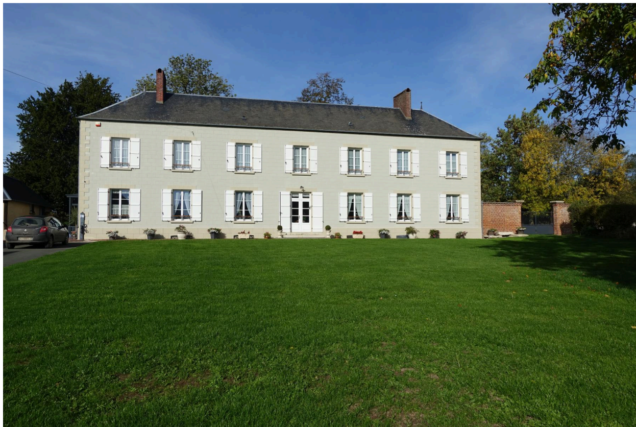
Logis vu depuis la cour.
