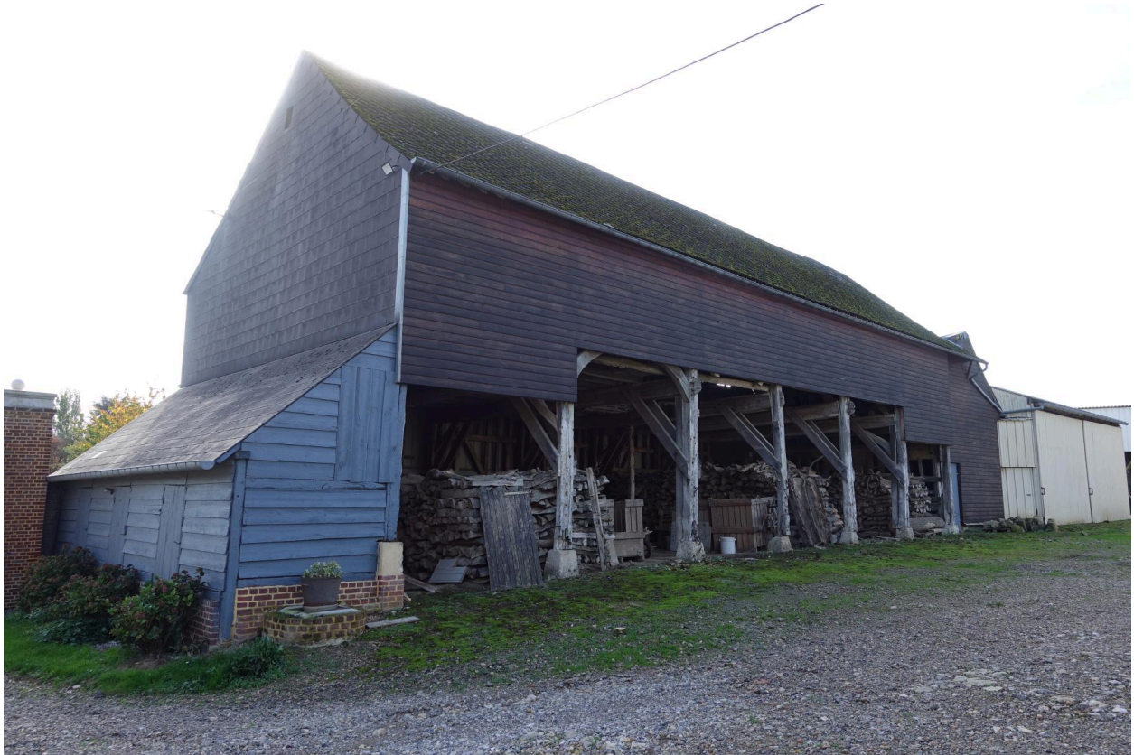
Ancienne charreterie sur rue, vue depuis la cour.
