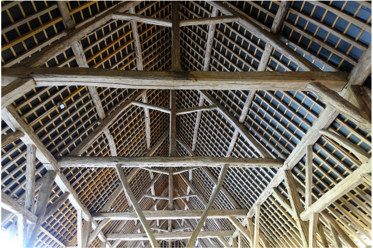
Charpente de l'ancienne grange et pressoir.
