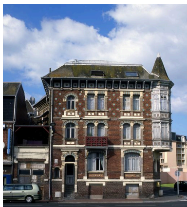
Vue depuis l'avenue du Maréchal-Foch.
