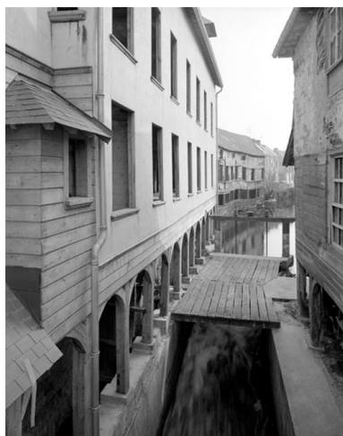
Élévation sur le bras des Clairons, en 1990. Phot. Thierry Lefébure IVR22_19908001850V
