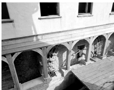
Coursier et roue hydraulique. Phot. Thierry Lefébure IVR22_19908001840X
