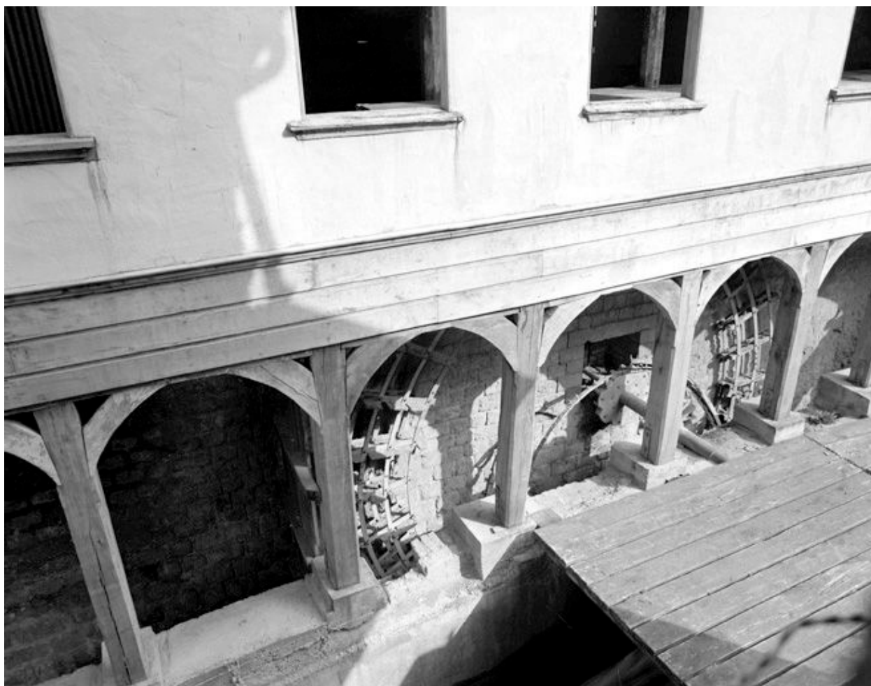
Coursier et roue hydraulique.
