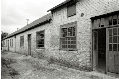
Ateliers de fabrication, élévation antérieure, en 1990. Phot. Francis Dubuc IVR22_19908000096Z
