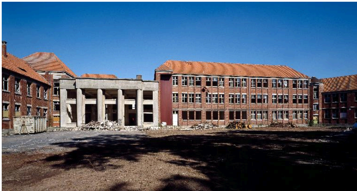
Vue de la façade sur cour, en direction de la rue Belzaize.
