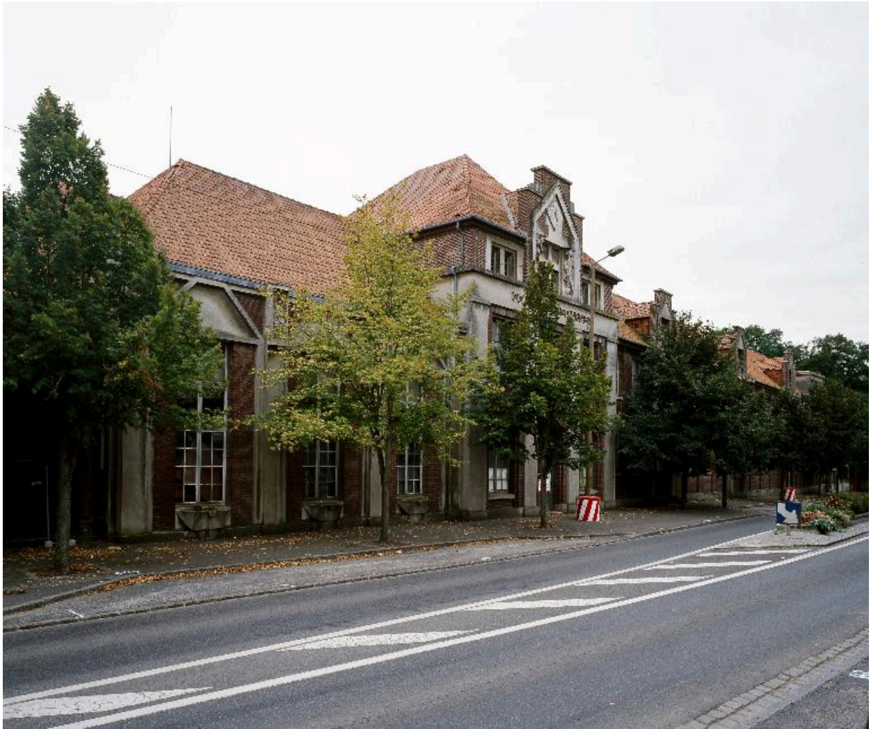
Façade sur l'avenue Danicourt.
