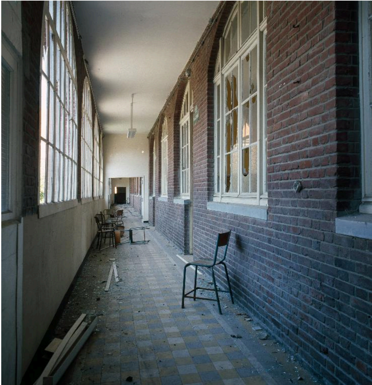
Couloir donnant accès aux salles de cours.
