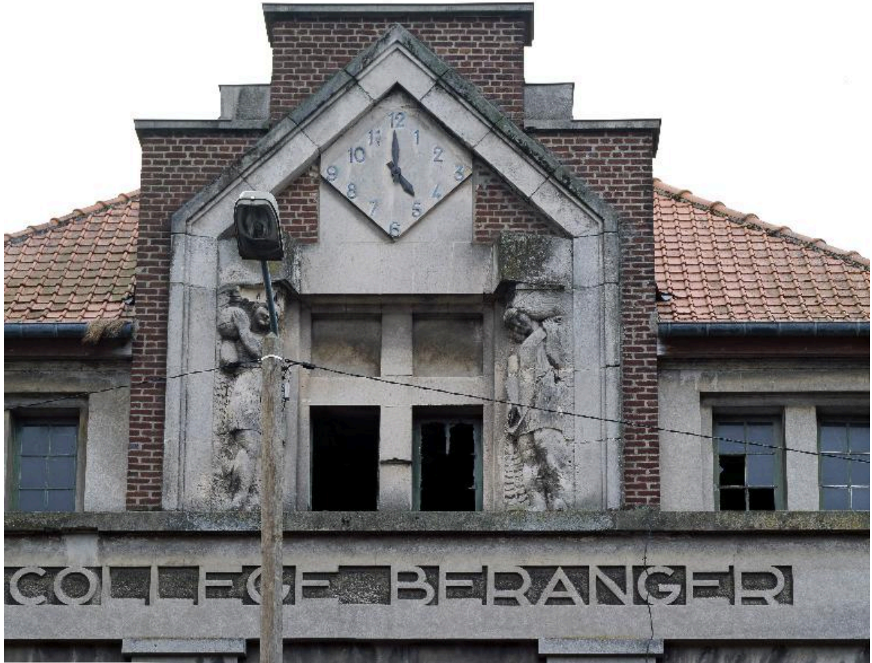
Détail du fronton de l'avant-corps de l'entrée sur l'avenue Danicourt : atlantes sculptées en pierre.
