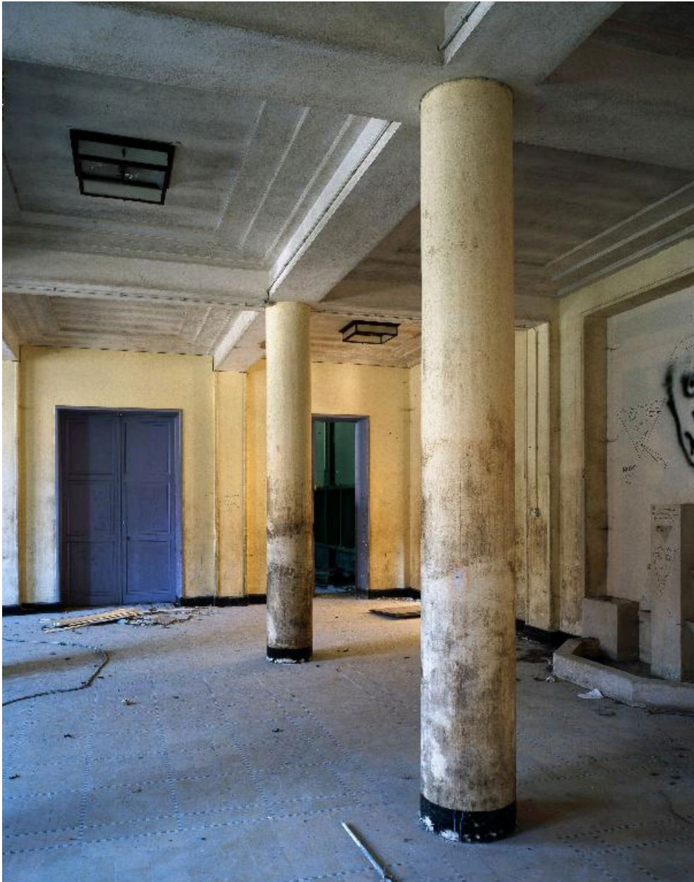
Vue intérieure de l'entrée principale.
