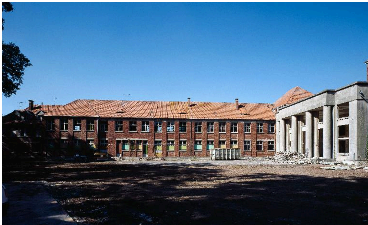
Façade postérieure, avenue Danicourt.
