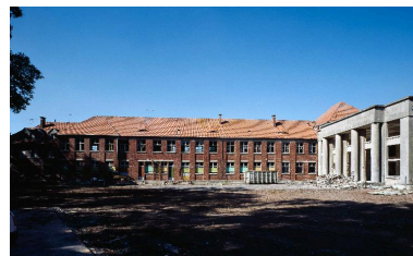
Façade postérieure, avenue Danicourt. Phot. Thierry Lefébure IVR22_20058002459PA
