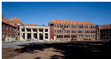
Vue de la façade sur cour, en direction de la rue Belzaize. Phot. Thierry Lefébure IVR22_20058002458PA
