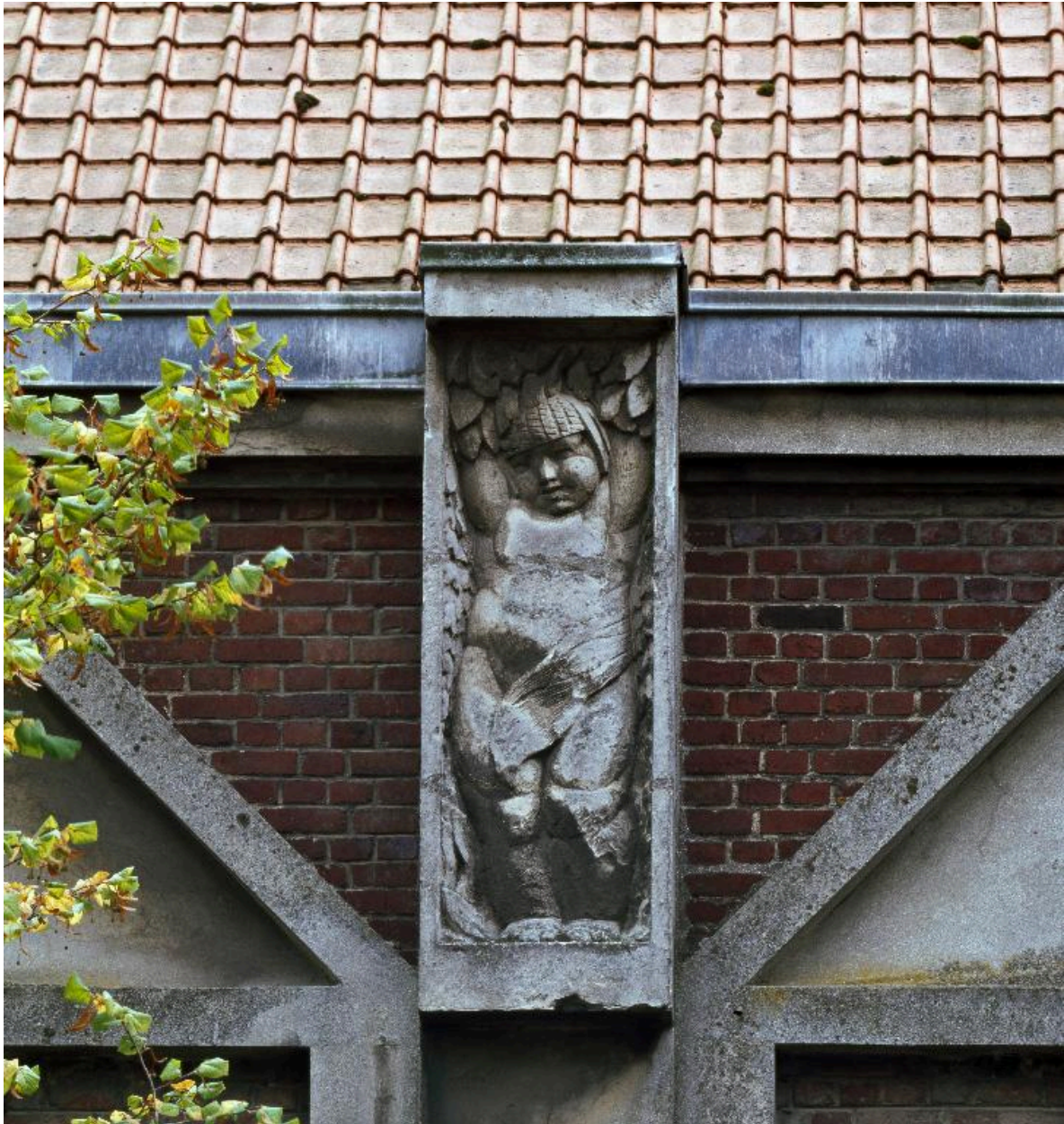
Détail du décor de la corniche (façade sur l'avenue Danicourt).
