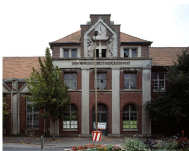
Vue de l'avant-corps de l'entrée sur l'avenue Danicourt. Phot. Thierry Lefébure IVR22_20058002463VA
