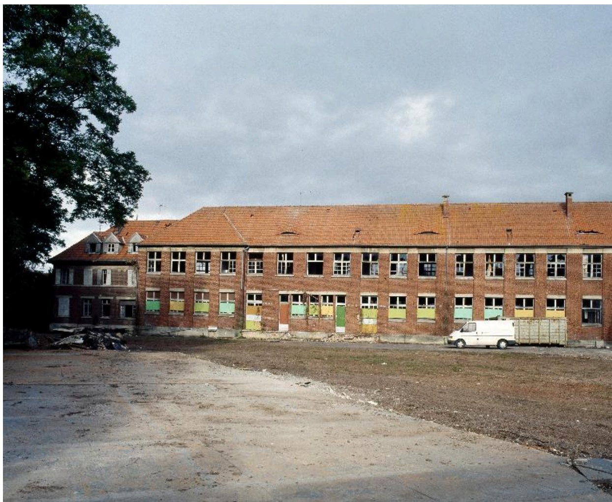
Façade postérieure, avenue Danicourt.
