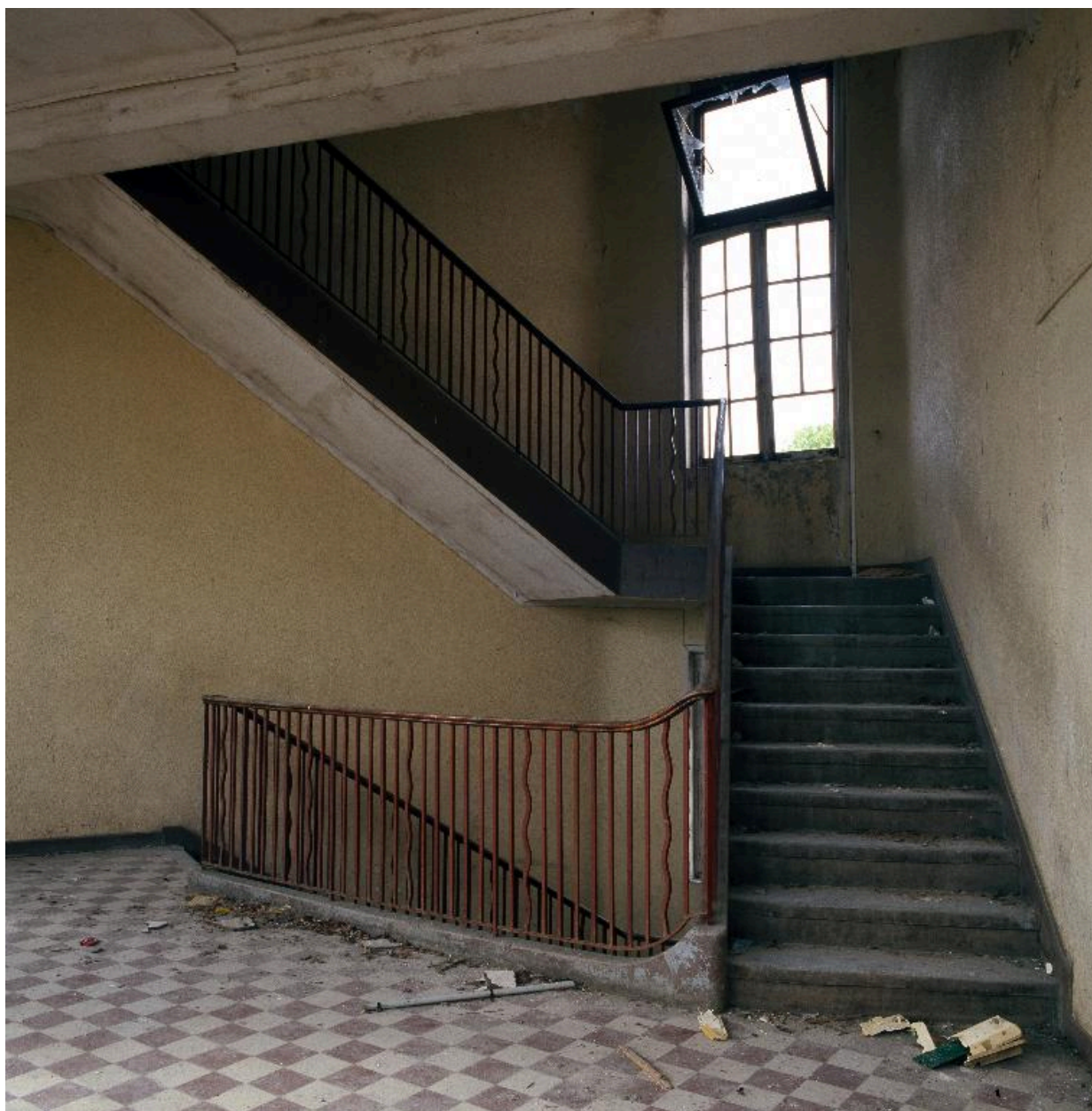
Vue de l'escalier.
