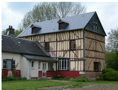
Vue d'ensemble du moulin, façade antérieure. Phot. Bertrand Fournier IVR22_20056000795NUCA
