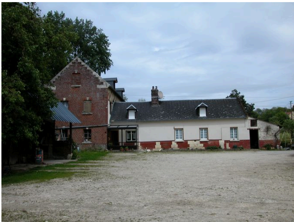
Façade sur cour du pignon du moulin et de logement de meunier.
