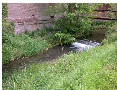
La chute du moulin. Phot. Bertrand Fournier IVR22_20056000799NUCA
