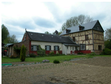
Vue d'ensemble du moulin à blé et de l'habitation en retour. Phot. Bertrand Fournier IVR22_20056000792NUCA
