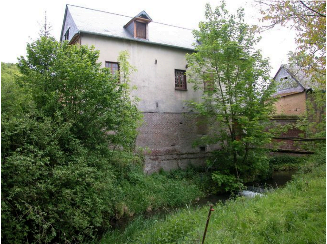
Façade postérieure, sur la rivière, du moulin à blé.
