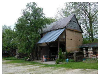
La remise et le bucher. Phot. Bertrand Fournier IVR22_20056000800NUCA
