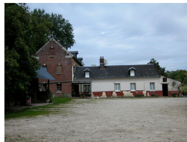
Façade sur cour du pignon du moulin et de logement de meunier. Phot. Bertrand Fournier IVR22_20056000793NUCA
