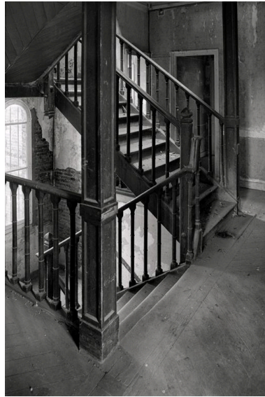
Vue de la cage d'escalier, depuis le 1er étage (avant restauration). Phot. Pierre-Yves Brest IVR22_19990204140Z
