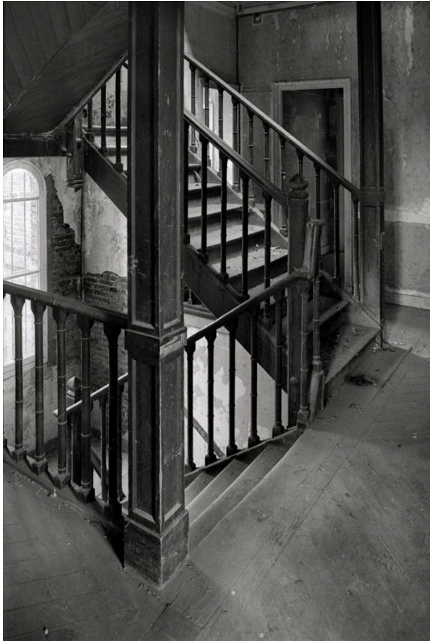
Vue de la cage d'escalier, depuis le 1er étage (avant restauration).
