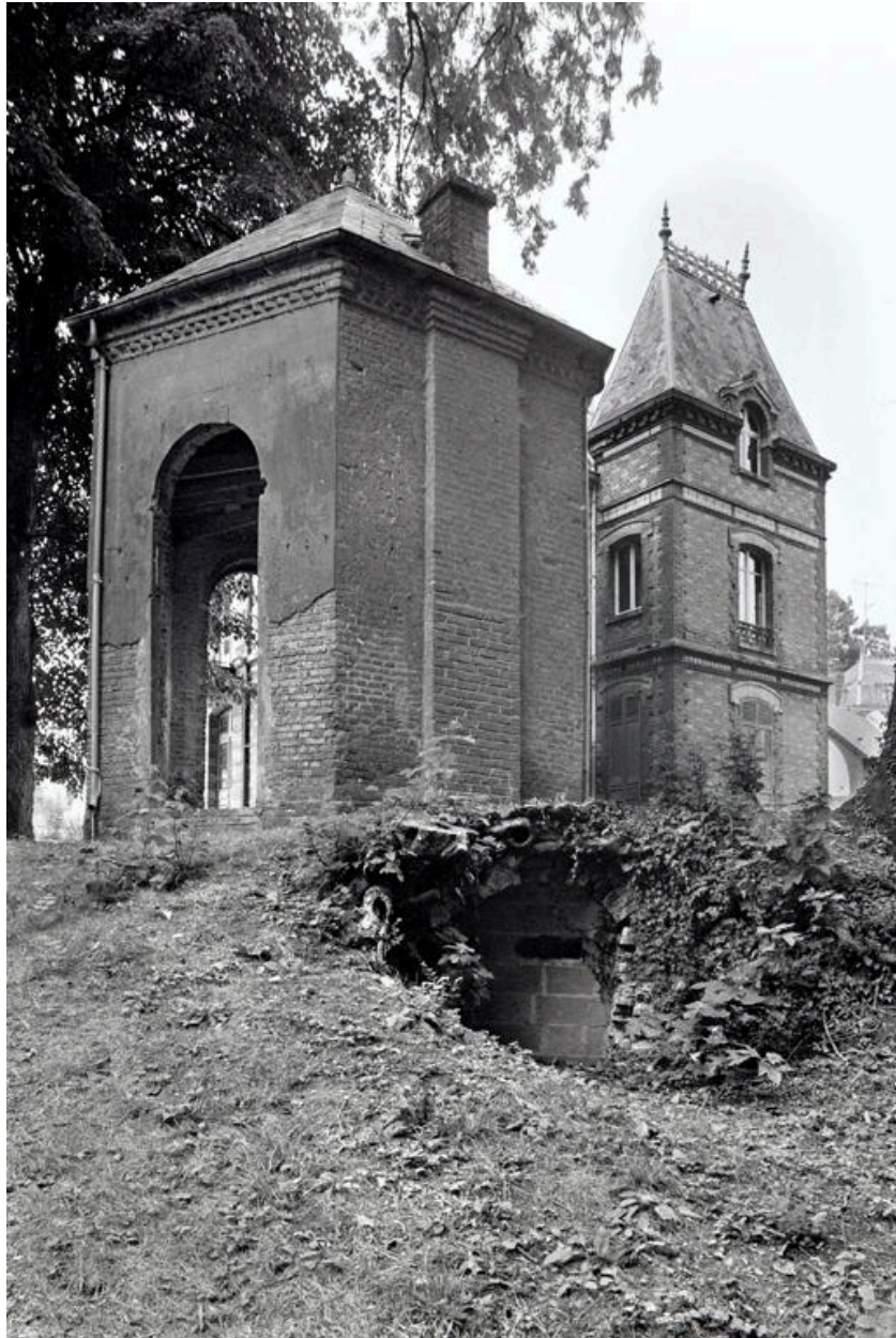
Vue du kiosque de la maison.
