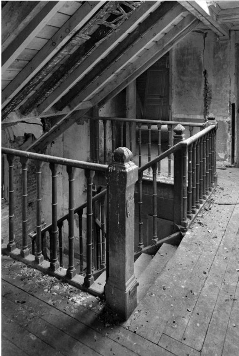
Vue de la cage d'escalier de la maison.
