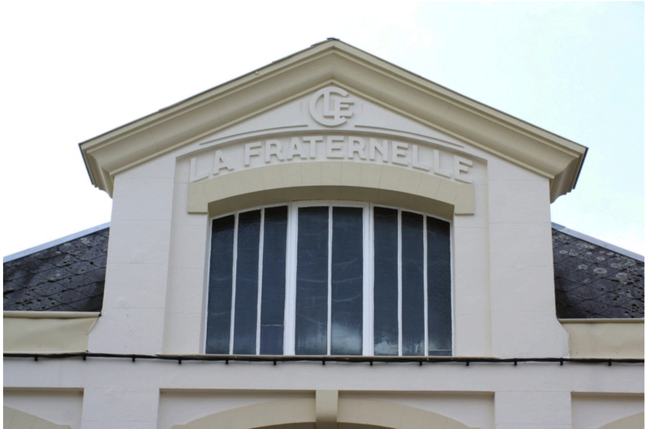
Détail de la façade antérieure de la fonderie, rue Jacques-Lescot.
