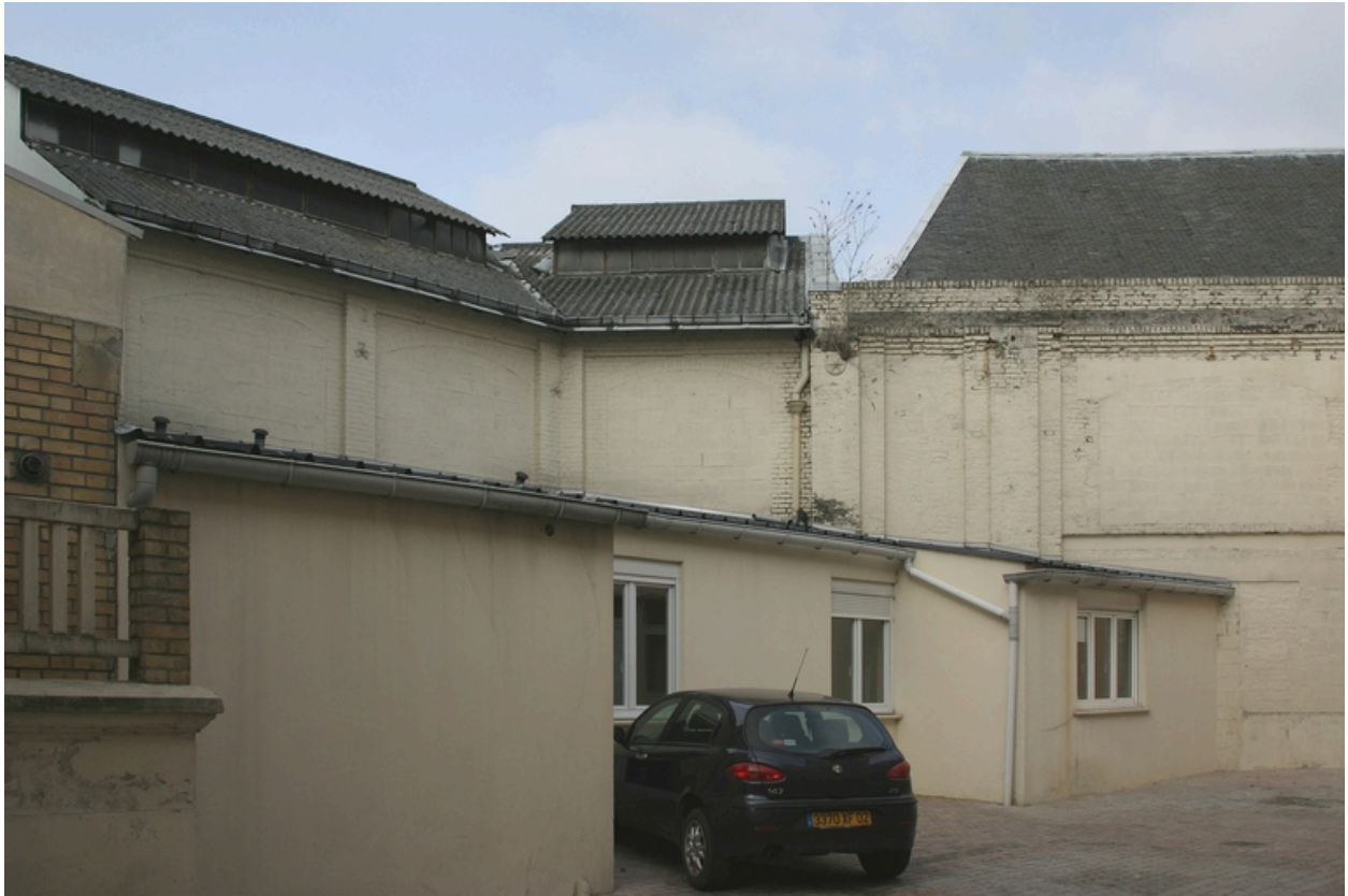
Vue de l'ancienne fonderie depuis la cour.
