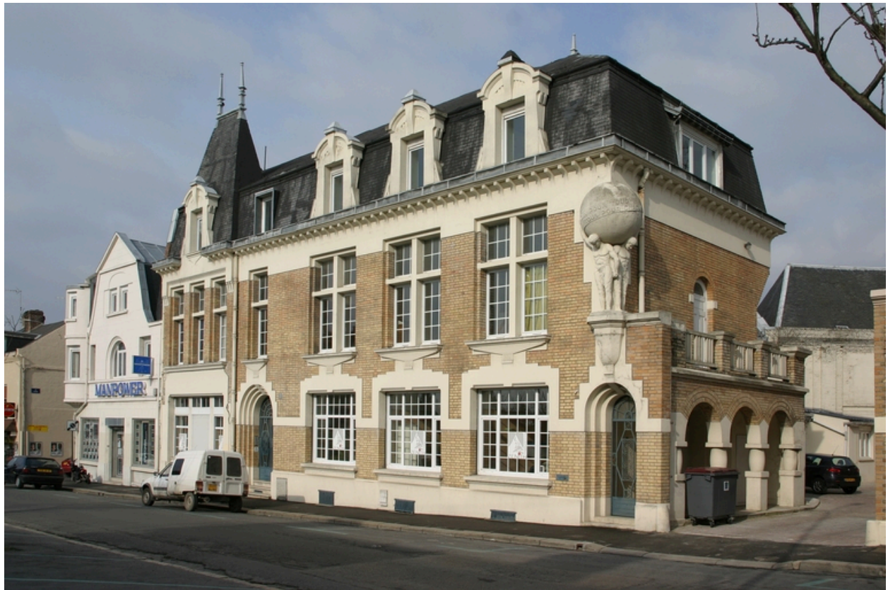
Immeuble de 1928 en bordure du boulevard Faidherbe : à droite, on distingue l'ancien atelier de fonderie.
