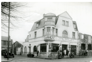
L'angle de la rue Blanqui et du boulevard Faidherbe dans les années 1920 : à droite, les ruines de la fonderie (AC Saint-Quentin). Phot. Pillet Frédéric IVR22_20050205781NUCAB
