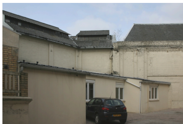
Vue de l'ancienne fonderie depuis la cour.
