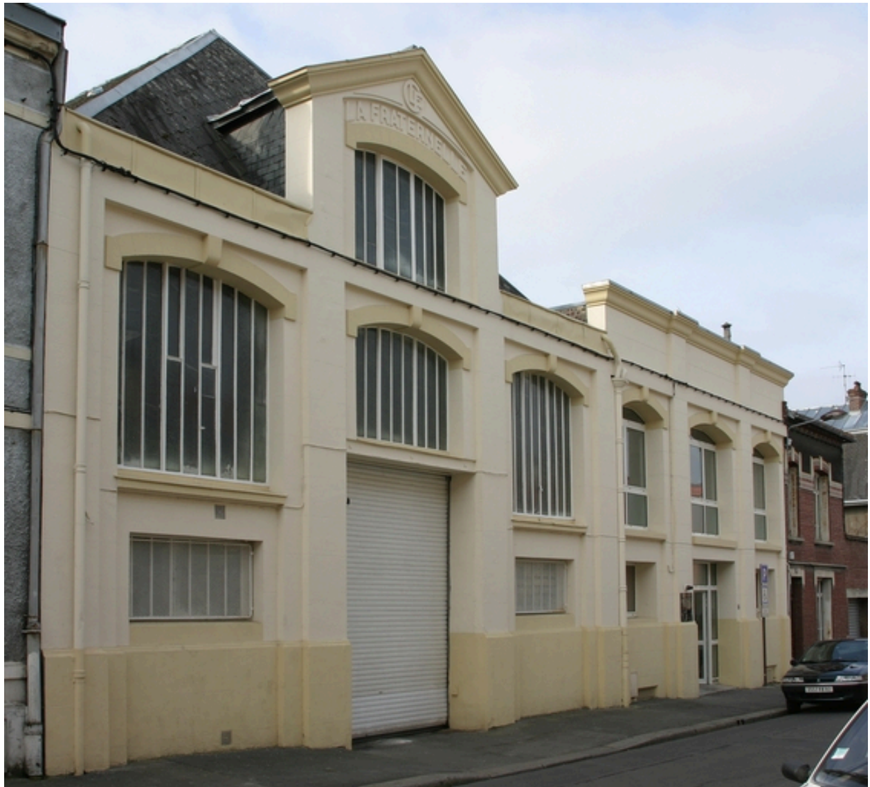
Façade antérieure de la fonderie des années 1860, rue Jacques-Lescot. Le bâtiment de droite, dont la façade est homogène avec celle de l'ancienne fonderie, a été intégré ultérieurement au site.
