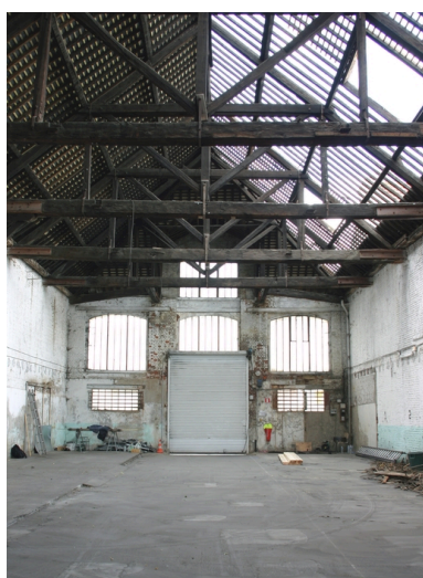
Vue intérieure de la fonderie des années 1860. Phot. Frédéric Pillet IVR22_20050205981NUCA
