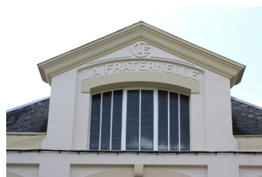
Détail de la façade antérieure de la fonderie, rue Jacques-Lescot. Phot. Frédéric Pillet IVR22_20050205784NUCA
