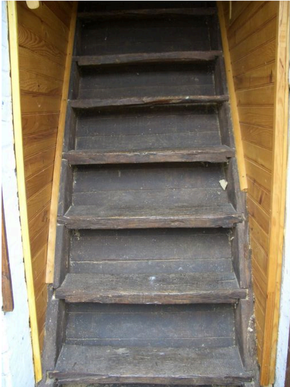
Escalier d'accès au grenier pratiqué dans la façade.
