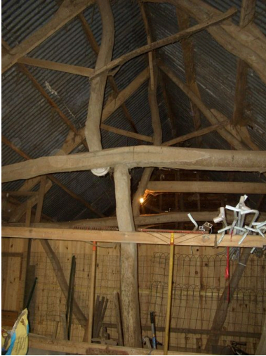
Vue intérieure. Phot. Inès Guérin IVR22_20078005153NUCA
