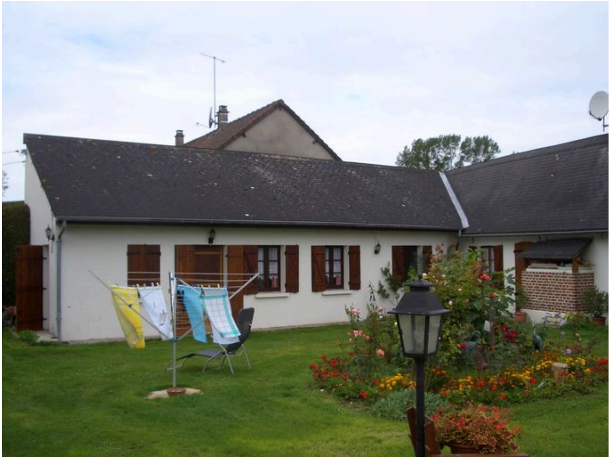
Vue des dépendances situées perpendiculairement au logis.
