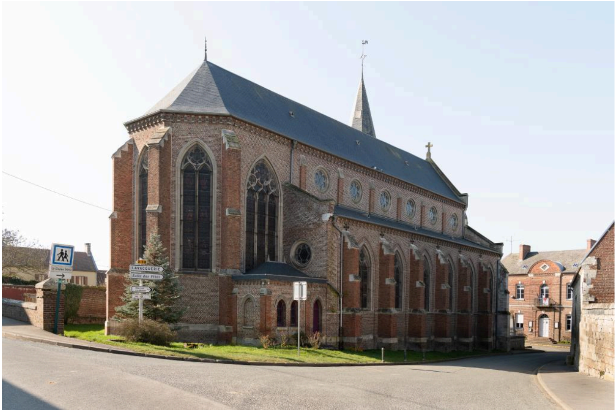
Vue du chevet et de l'élévation nord.
