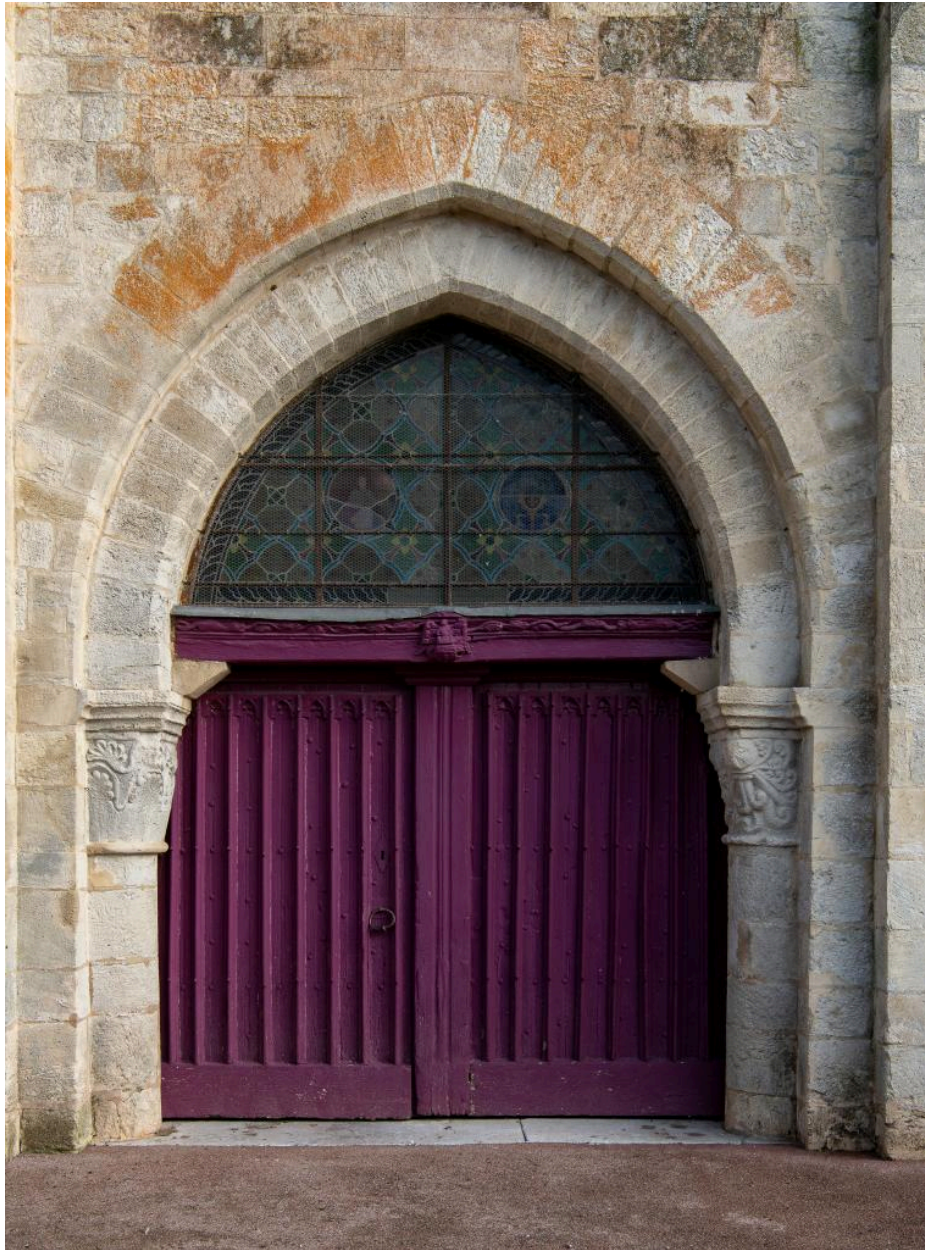
Vue du portail roman du clocher-porche depuis l'ouest.
