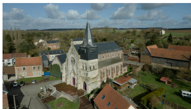
Vue aérienne de l'église depuis le sud-ouest. Phot. Marc Kérignard IVR32_20226000159NUCA
