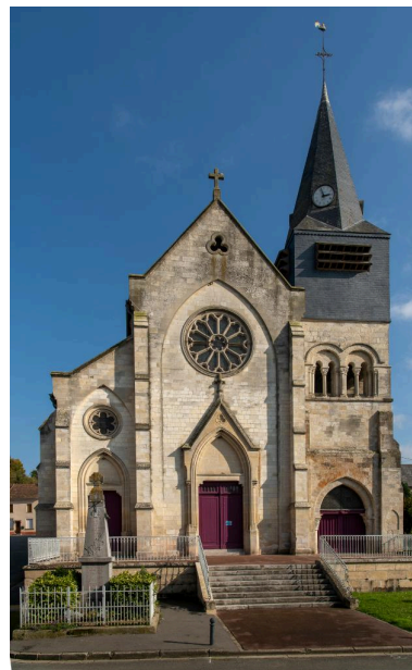
Vue générale de la façade occidentale. Phot. Marc Kérignard IVR32_20216001213NUCA
