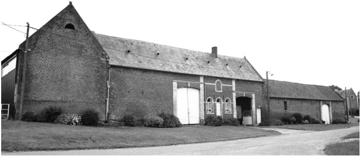
Vue générale depuis le nord.
