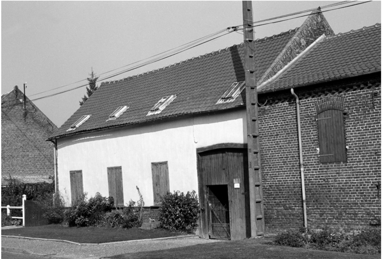
Vue de l'atelier des métiers à tisser qui forme le côté sud-ouest de la cour.
