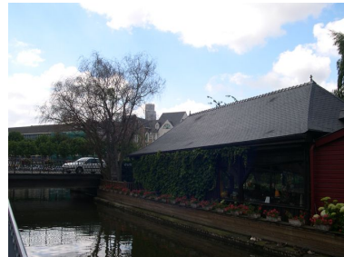
Vue de l'atelier. Phot. Isabelle Barbedor IVR22_20048010318NUCA
