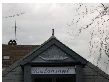
Détail sur le décor du pignon de la lucarne de l'atelier. Phot. Isabelle Barbedor IVR22_20048010319NUCA
