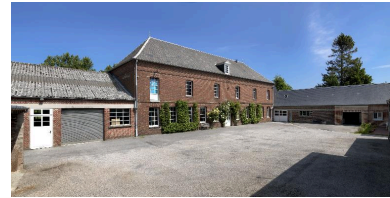
Vue générale. Phot. Thierry Lefébure IVR22_20158000441NUC2AQ
