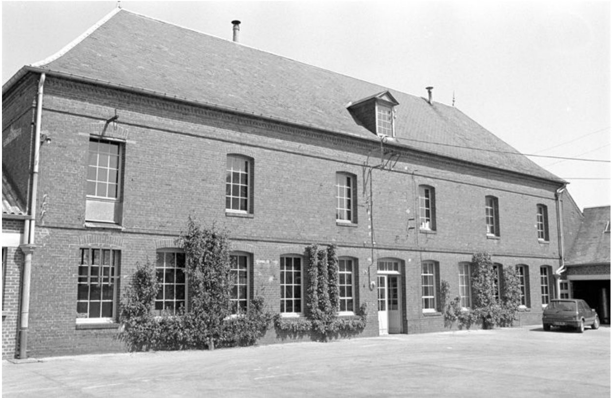
Atelier de fabrication, élévation antérieure, 1990.
