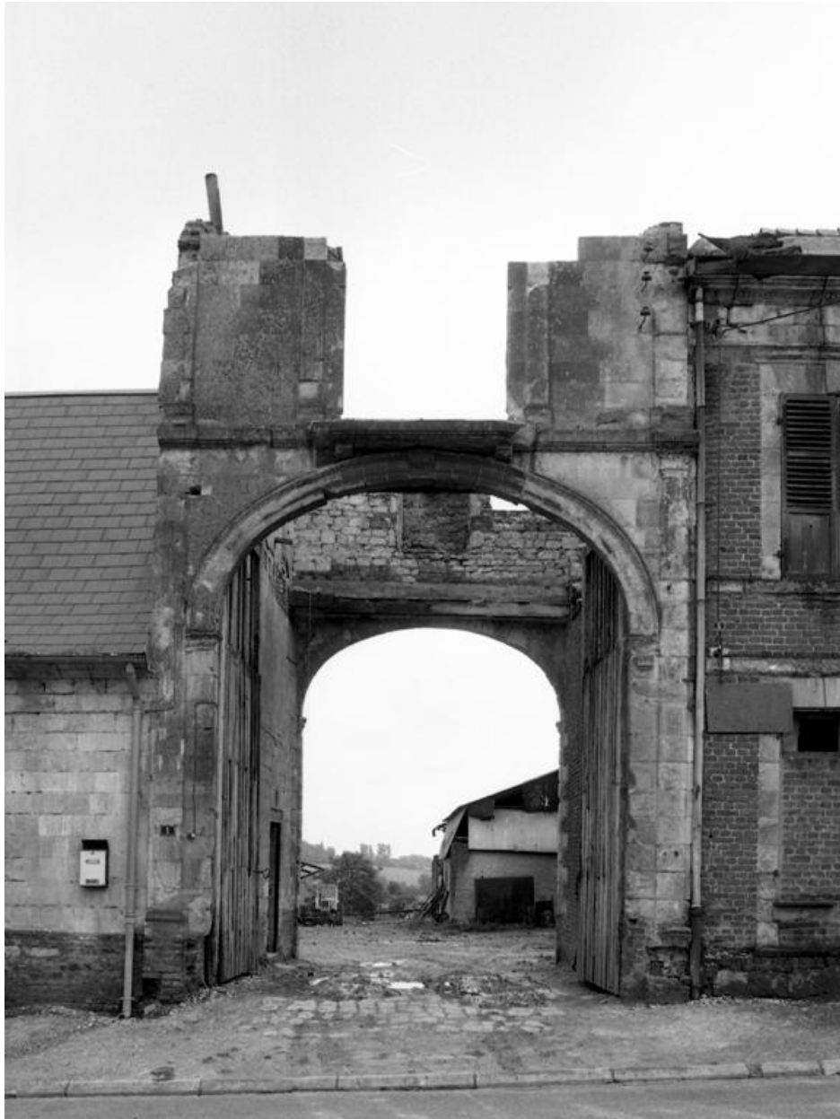
Vue de la façade du pigeonnier porche.
