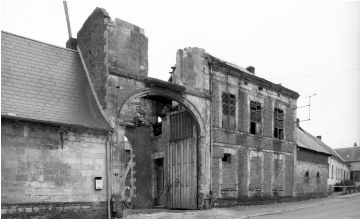
Vue d'ensemble du pigeonnier porche, du logis attenant et d'une étable, depuis l'est.
