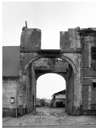
Vue de la façade du pigeonnier porche. Phot. Thierry Lefébure IVR22_19920201049Z
