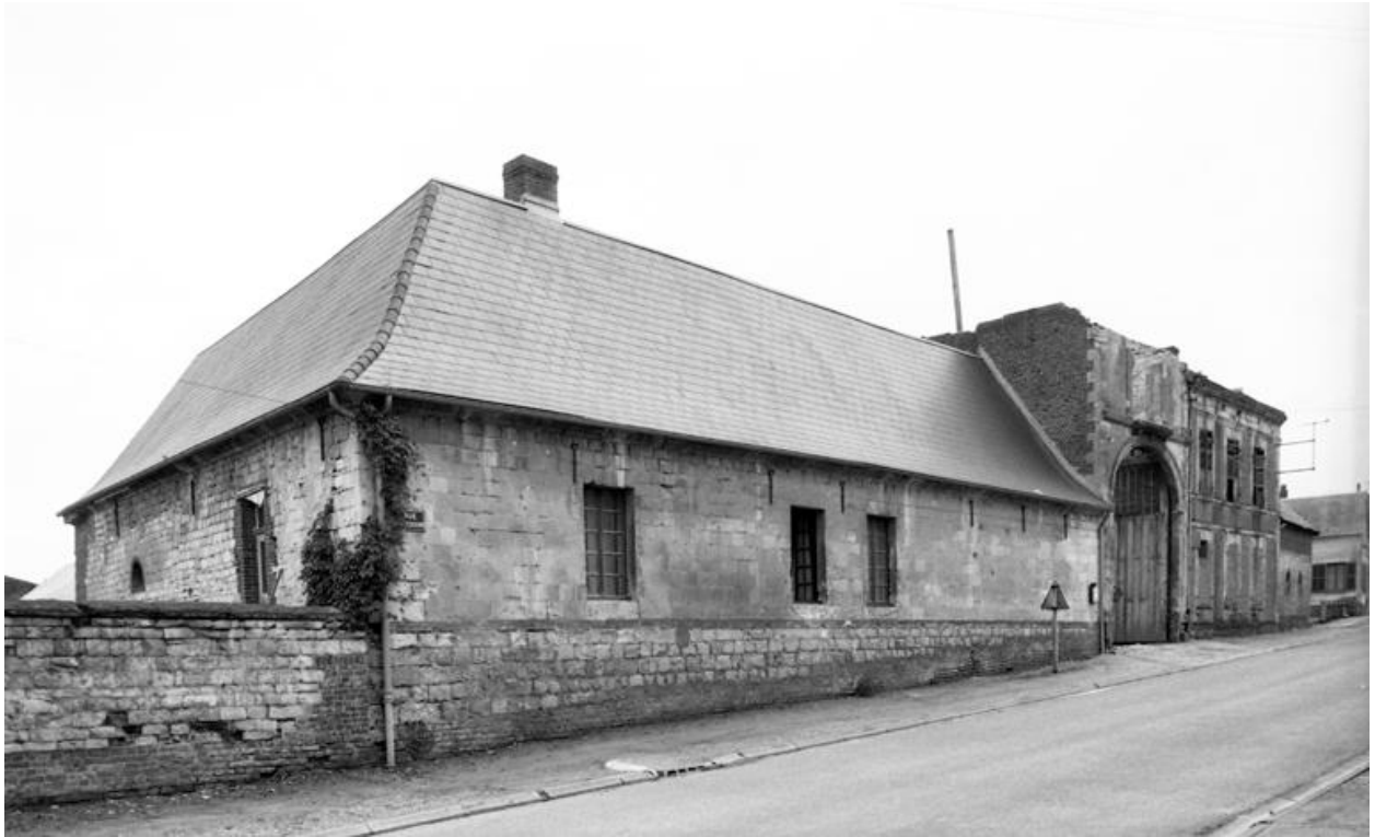
Vue d'ensemble des bâtiments sur rue, depuis l'est.
