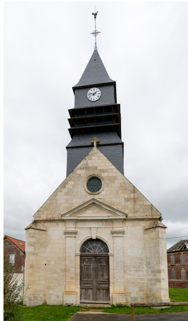
Portail occidental. Phot. Marc Kérignard IVR32_20246000112NUCA
