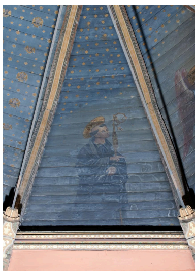
Détail du décor du quartier intérieur gauche du lambris de couverture de l'abside : saint Benoît. Phot. Pierre Thibaut IVR32_20225900316NUCA
