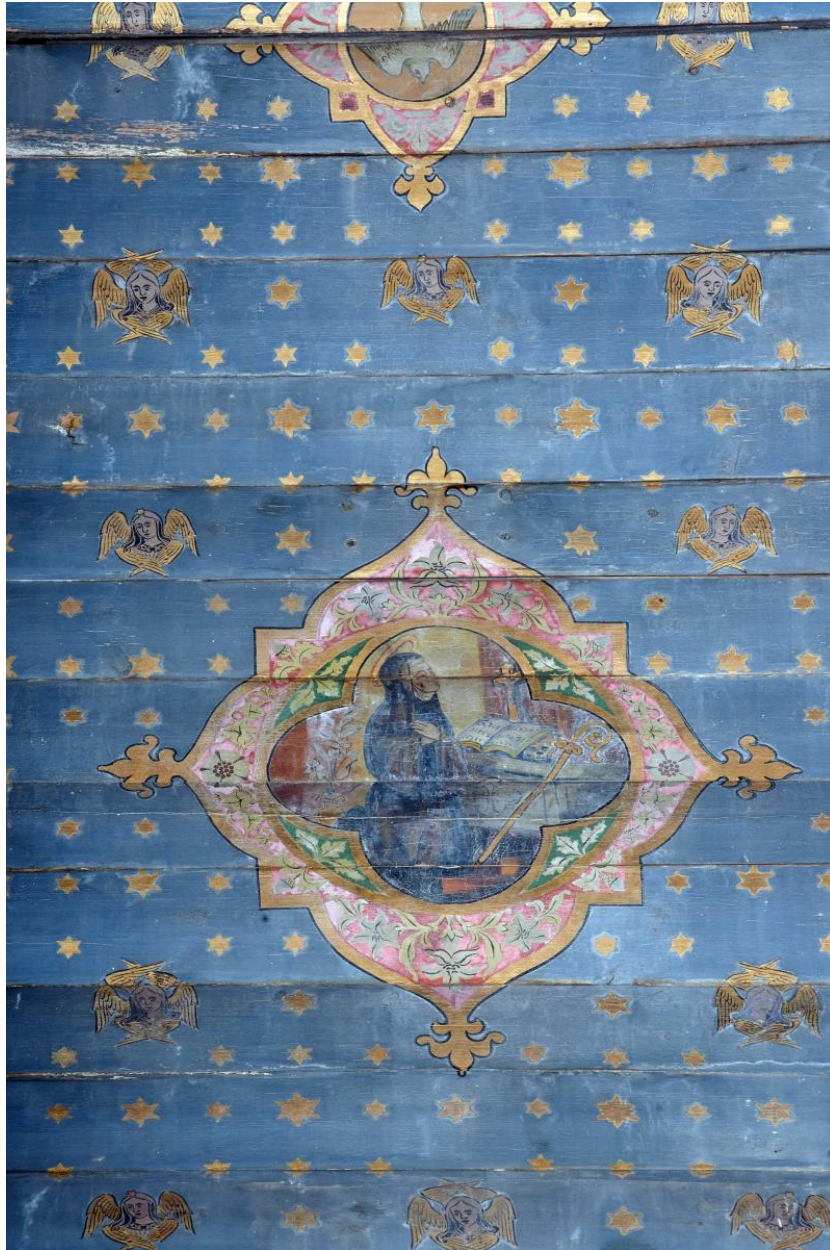
Détail d'un personnage peint sur le lambris de couverture de la nef. Médaillon 5 : sainte Scolastique (?).
