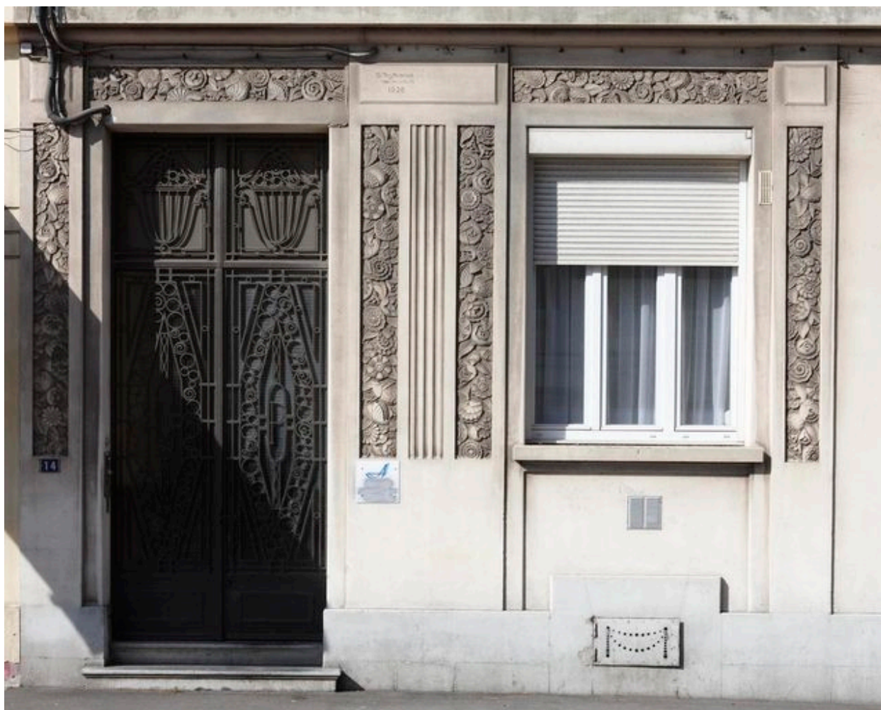
Rez-de-chaussée du 14 rue Chanzy.
