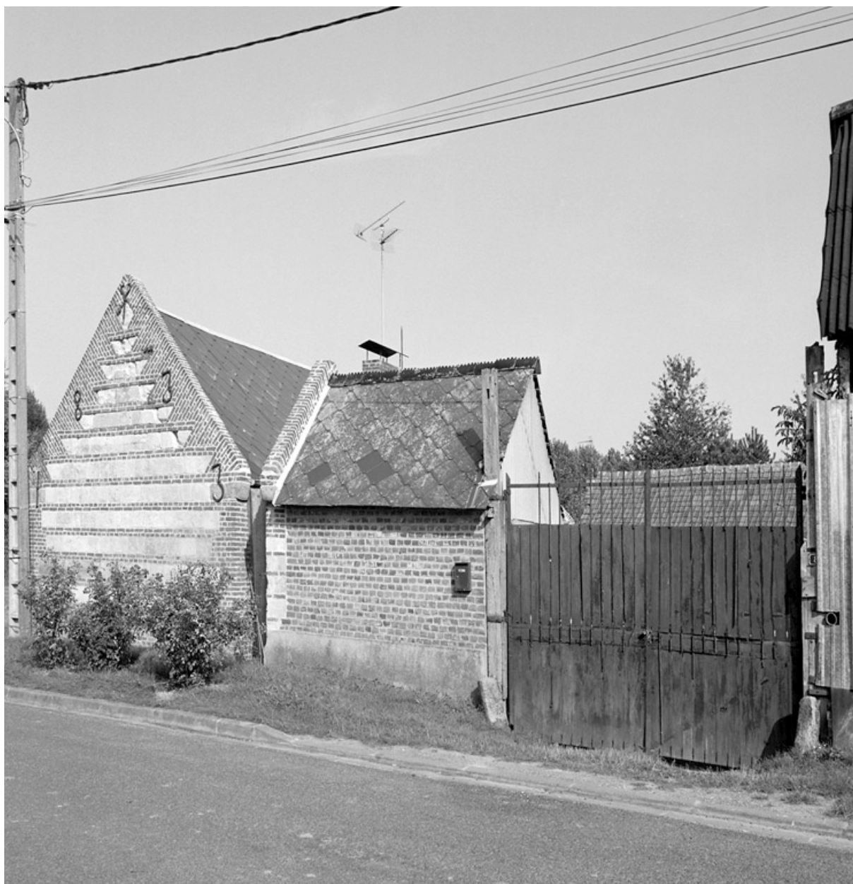
Vue d'ensemble, sur rue.
