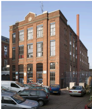
Élévation antérieure et flanc droit. Phot. Pierre Thibaut IVR31_20155900644NUCA
