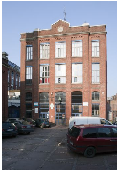
Élévation antérieure. Phot. Pierre Thibaut IVR31_20155900643NUCA
