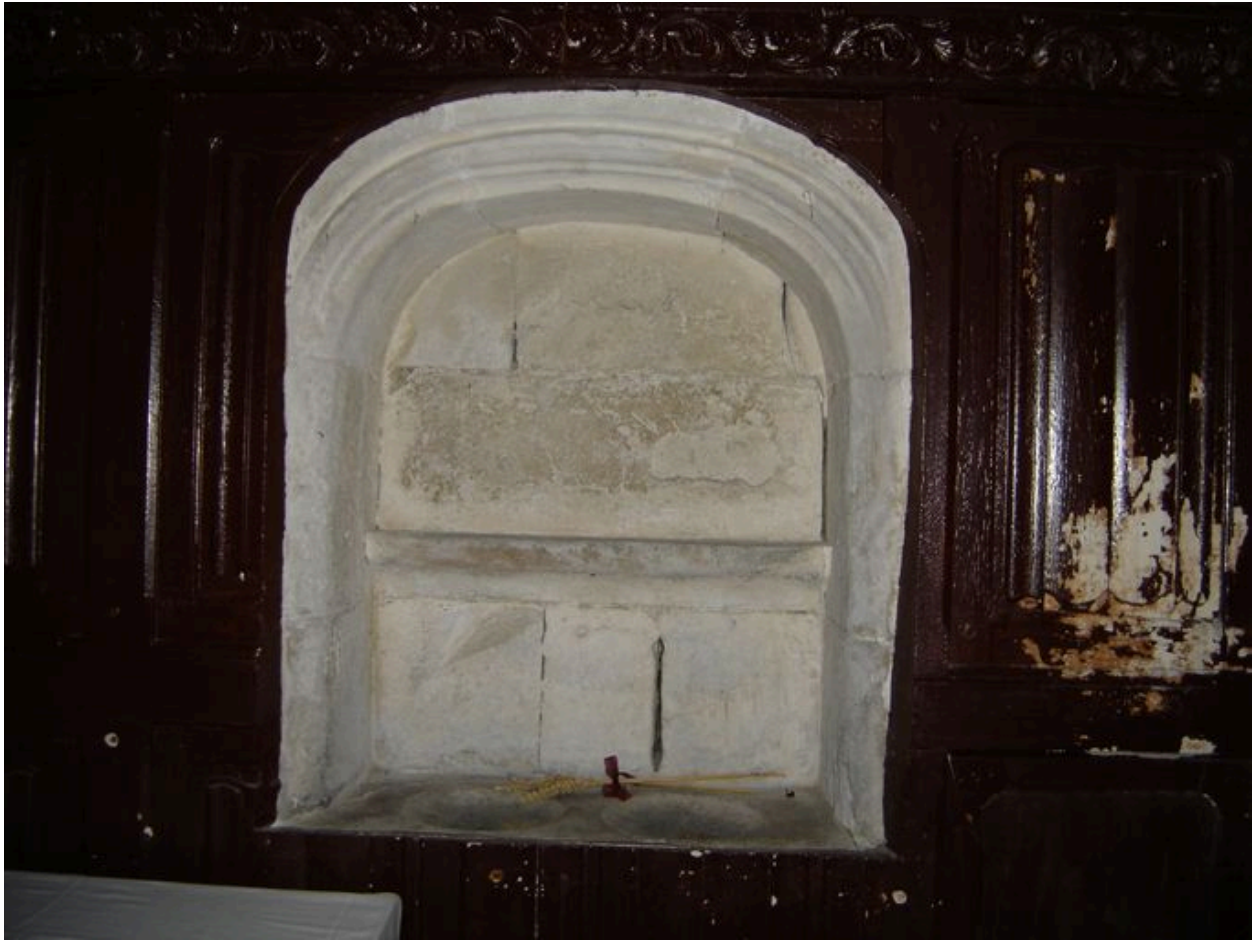
Vue de la niche du choeur.
