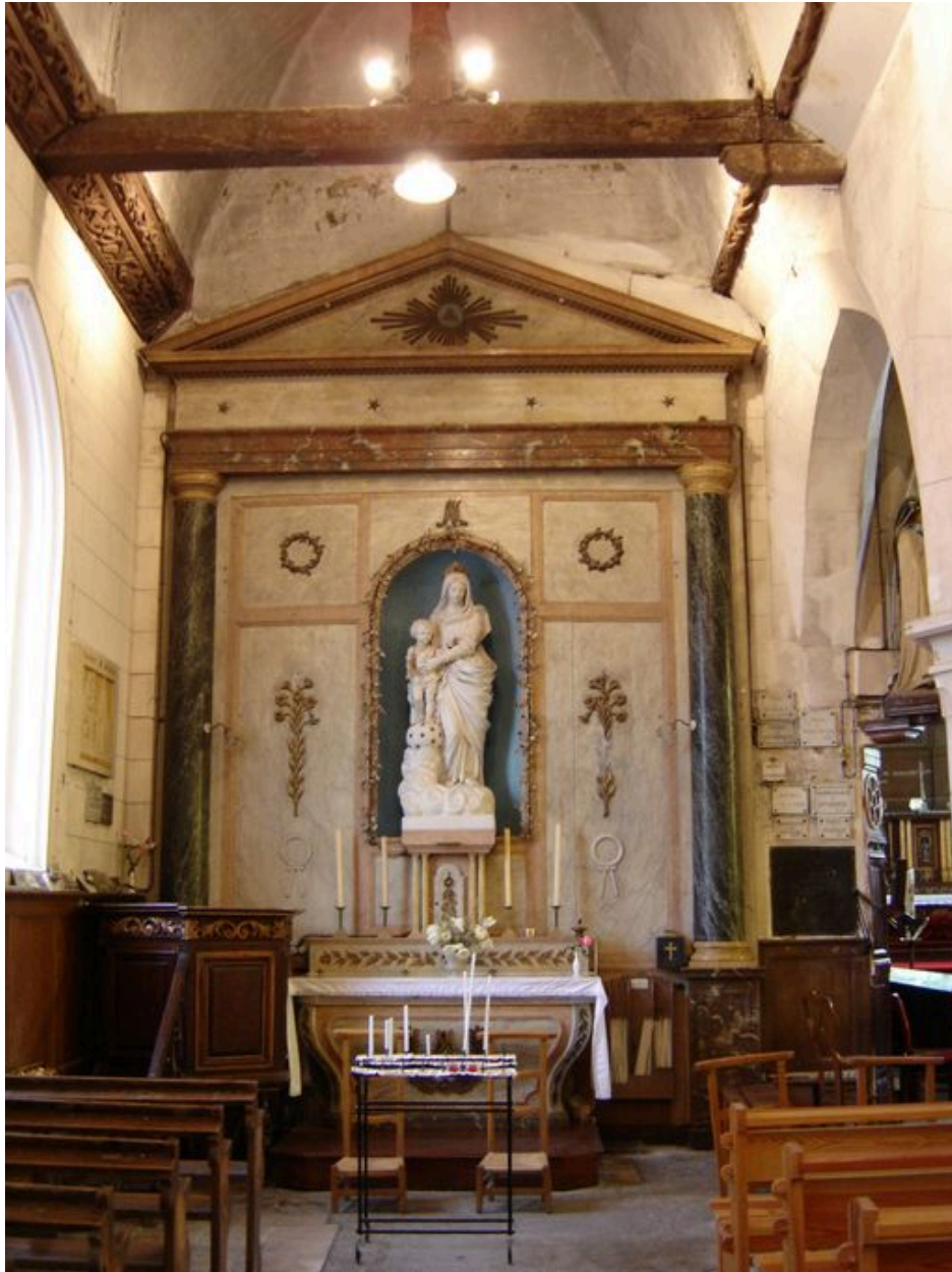
Vue intérieure du bas-côté nord.
