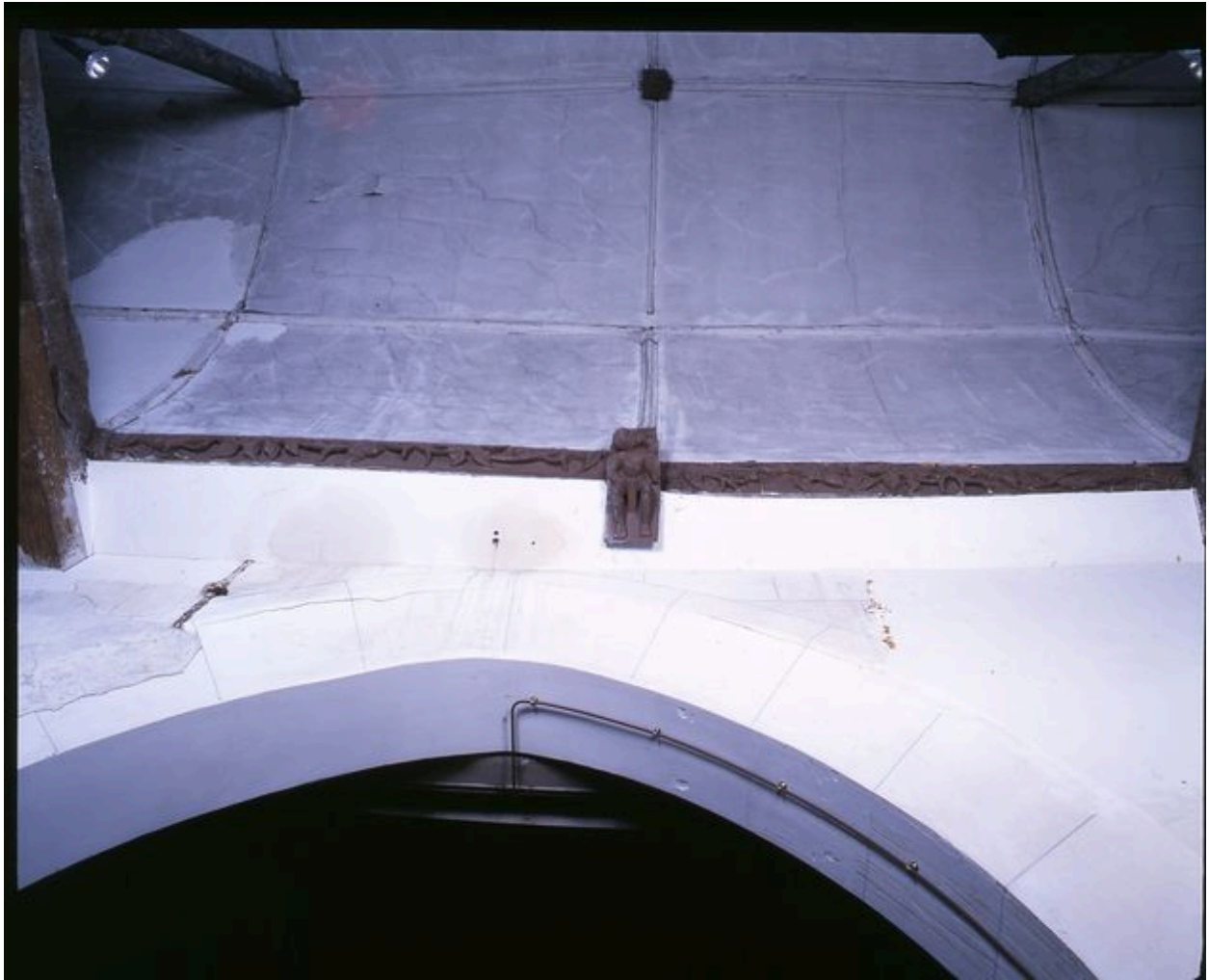
Vue détaillée d'une partie de la sablière basse du mur sud du bas-côté nord.
