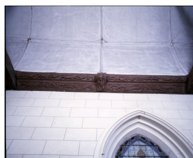
Vue détaillée d'une partie de la sablière haute du bas-côté nord. Phot. Irwin Leullier IVR22_20068000554XA
