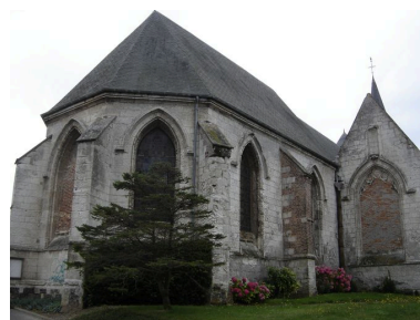
Vue du chevet. Phot. Inès Guérin IVR22_20078005270NUCA
