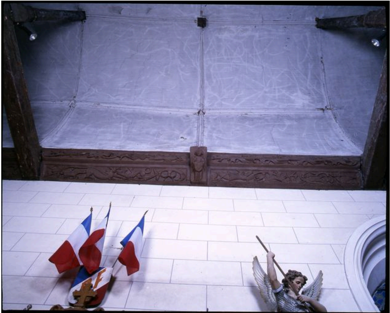
Vue détaillée d'une partie de la sablière haute du bas-côté nord.
