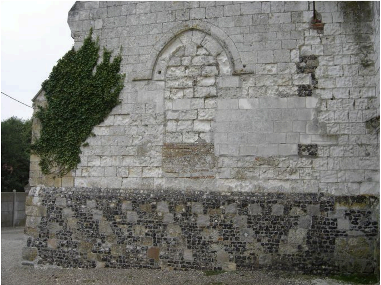
Vue du pignon ouest du bas-côté nord dont la fenêtre est condamnée.
