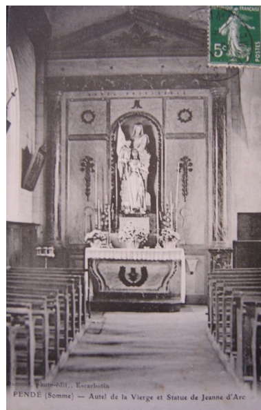
Vue de la chapelle nord au début du 20e siècle.
