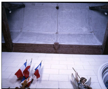
Vue détaillée d'une partie de la sablière haute du bas-côté nord. Phot. Irwin Leullier IVR22_20068000556XA
