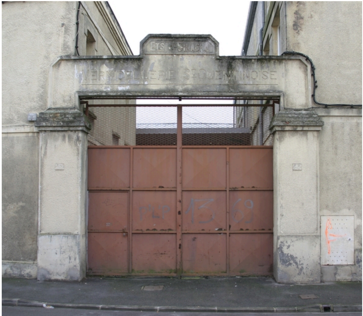
Portail d'entrée de la vermicellerie.
