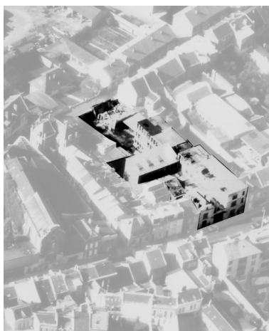
Vue aérienne du site en 1989. Phot. Pillet Frédéric, Autr. Phot'R IVR22_20060205575NUCA
