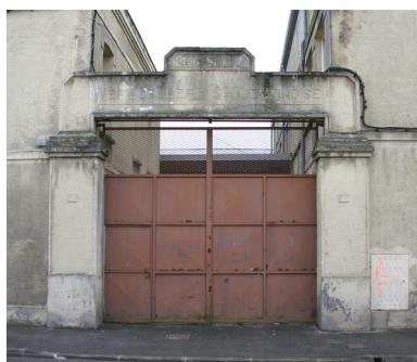
Portail d'entrée de la vermicellerie. Phot. Frédéric Pillet IVR22_20070205090NUCA
