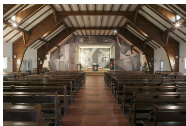
Vue générale vers le chœur. Phot. Pierre Thibaut IVR31_20155900469NUCA
