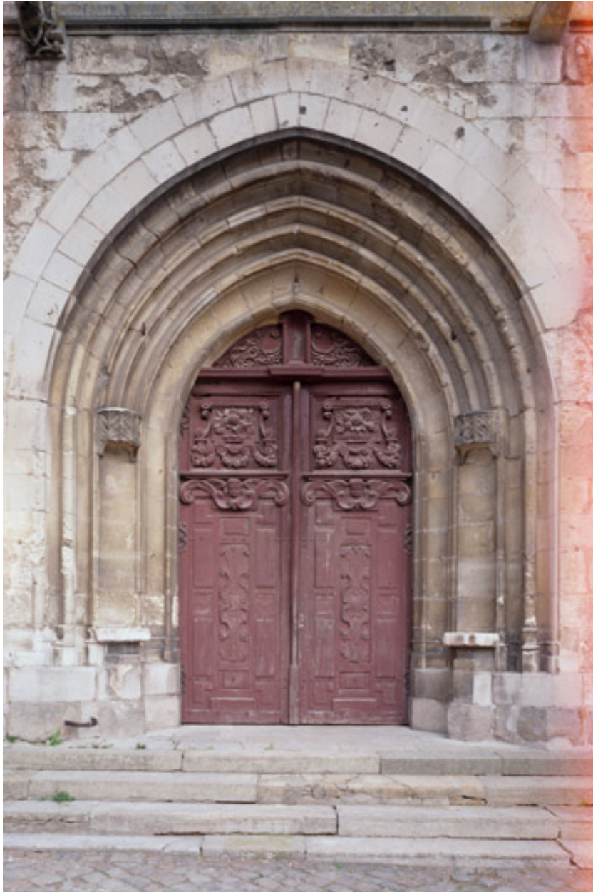
Le portail de la façade occidentale.
