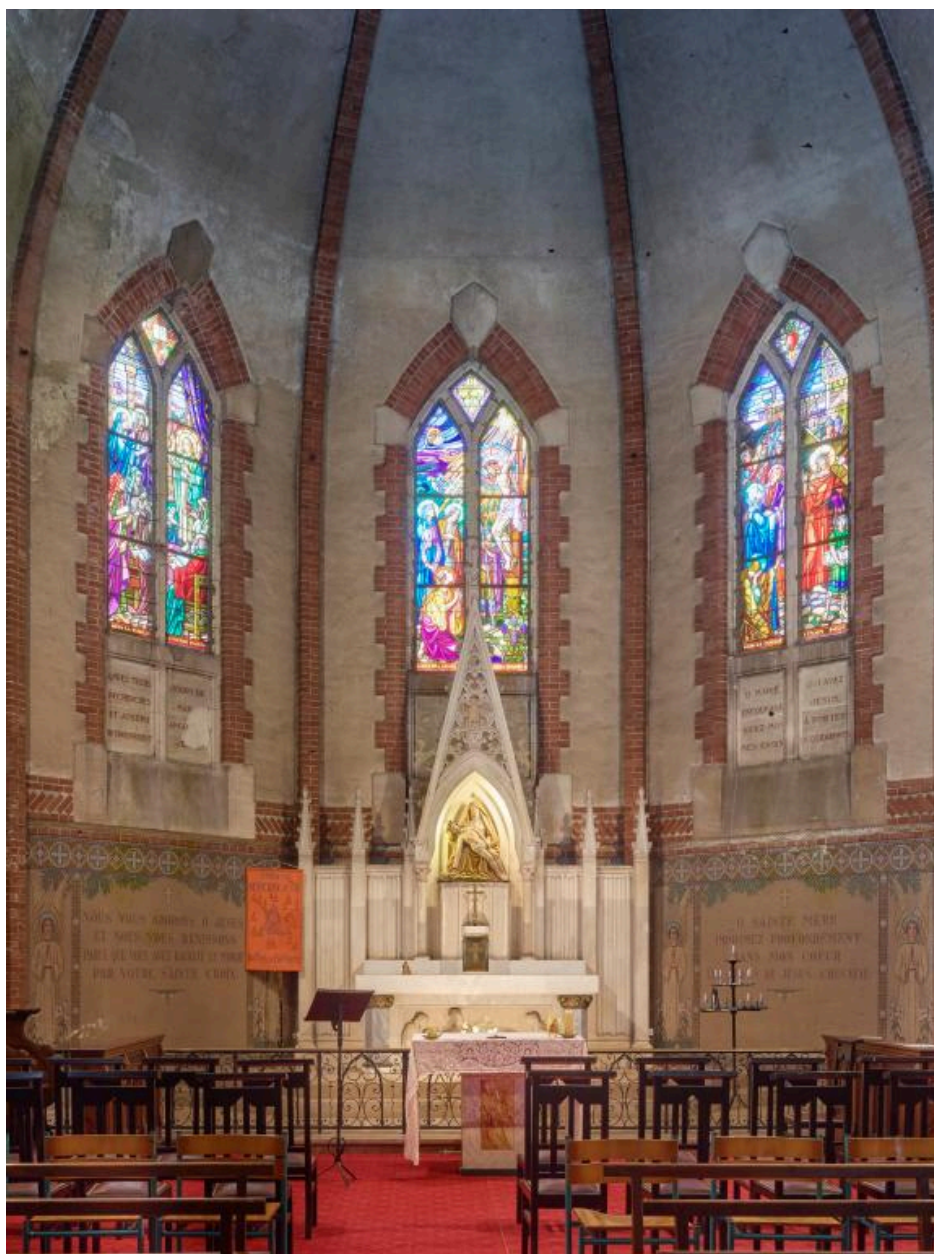
Chapelle Notre-Dame de Pitié : vue générale des baies.
