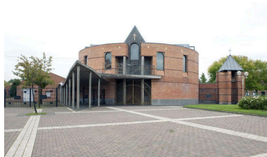
Élévation ouest. Phot. Pierre Thibaut IVR31_20155901092NUCA
