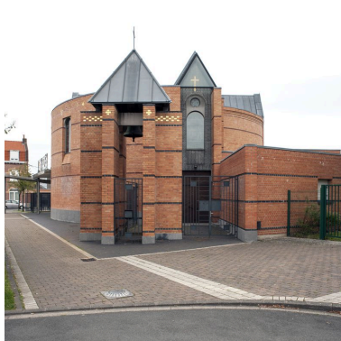
Élévation sud. Phot. Pierre Thibaut IVR31_20155901093NUCA
