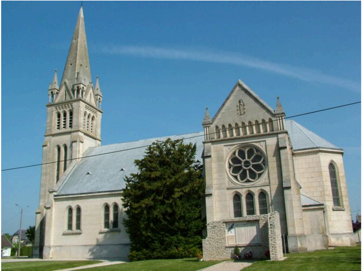
Vue de la face sud.
