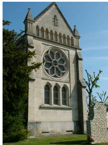
Vue du croisillon sud. Phot. Inès Guérin IVR22_20030202076NUCA
