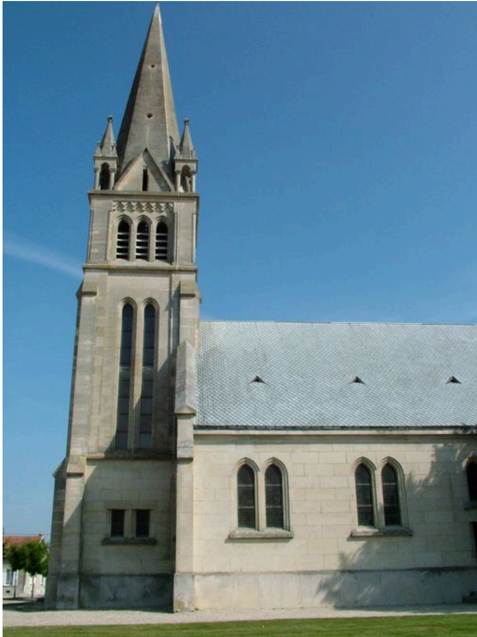
Vue latérale du clocher.
