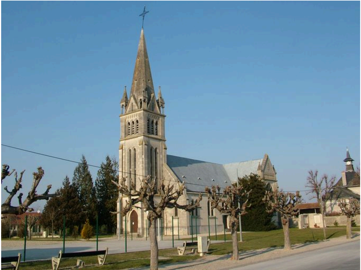
Vue générale de la façade ouest.
