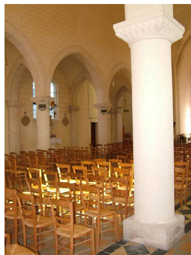
Vue intérieure. Phot. Irwin Leullier IVR22_20050200950NUCA
