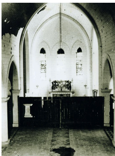
Vue intérieure de la nouvelle église après la Seconde Guerre mondiale (coll. part). Phot. Inès Guérin IVR22_20030202628NUCAB
